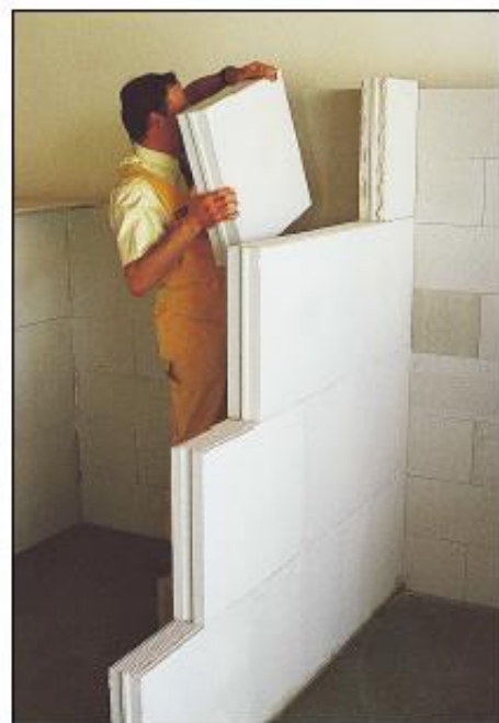
Figura 20: Montaje del sistema de partición interior Imagen tomada de catálogo YTONG
