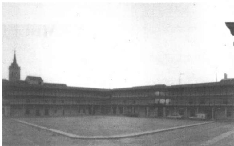
Fig. nº 51.— Plaza Mayor de Tembleque en la provincia de Toledo (Apud.: Díaz-Recaséns y Vázquez Consuegra, 1992: 136).
