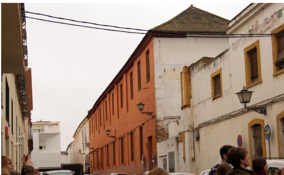
Fig. 49 Fotografía actual de la nave de los antiguos dormitorios del convento donde posteriormente se instauraron las escuelas municipales de Talavera. EP
