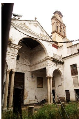
Fig. 73 Fotografía de la entrada a la iglesia por el compás en la actualidad. EP
