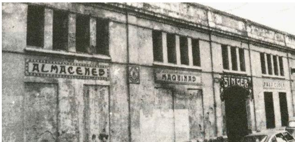
Fig. 42 Fotografía del almacén Singer en la década de los 80 con la azulejería original. Fuente: http://elcajondeloscristales.com/2013/12/13/nave-singer/
