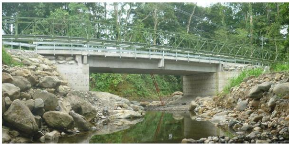
Figura 17. Vista lateral de puente sobre el Río Peje.
