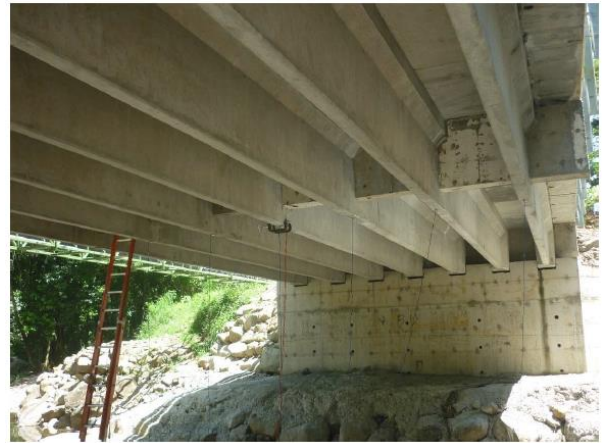
Figura 20. Vista inferior de la estructura.
