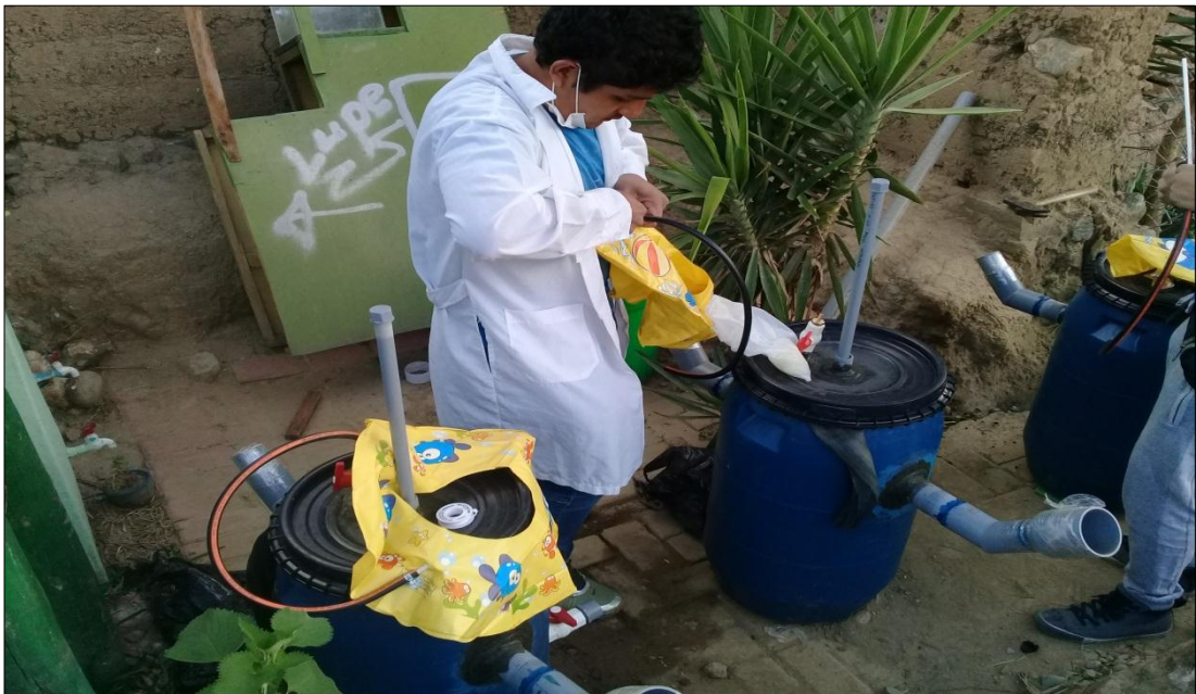
Ilustración 16. Instalación y arranque de los biodigestores de tipo semicontinuo.
