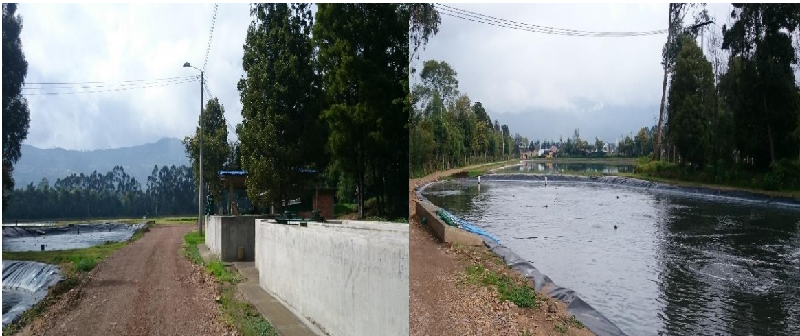
Figura 7. Planta de tratamiento de aguas residuales domésticas del municipio de Cajicá. Sección de rejillas de gruesos y finos, desarenador, trampa de grasas y lagunas anaerobia, facultativa y aerobia. Fuente: Autora.
