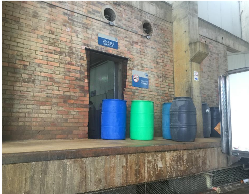
Figura 5. Frigorífico BLE. Zona de lavado de vísceras (no permitieron tomar fotografías en otras áreas del frigorífico). Fuente: Autora.
