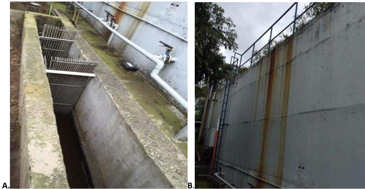
Figura 3. Planta de tratamiento de agua residual de la planta de beneficio del municipio de Tabio. A. Sección de cribado. B. Tanque de aireación. Fuente: Autora.
