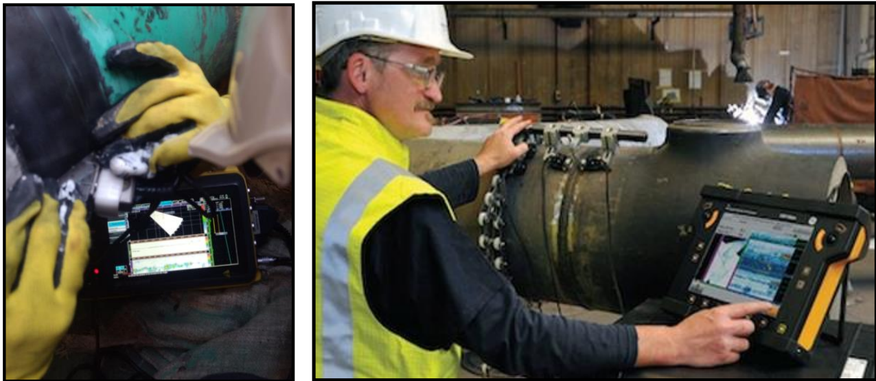
Figura 16.5. Aplicación del ensayo de ultrasonido en soldaduras (2, 140)
