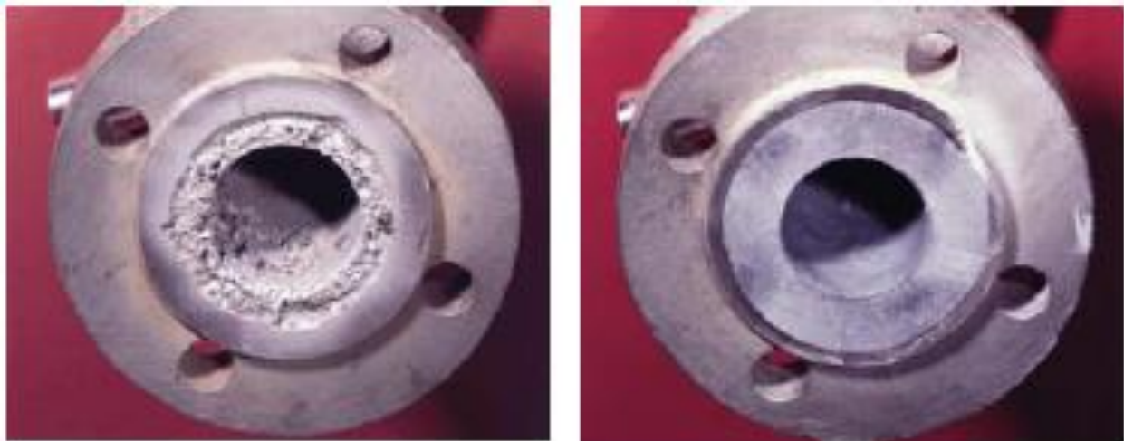
a) Pieza antes de reparar
