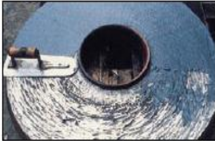
Figura 8.9. Aplicación de un revestimiento epóxido contra la abrasión (18, 33)
