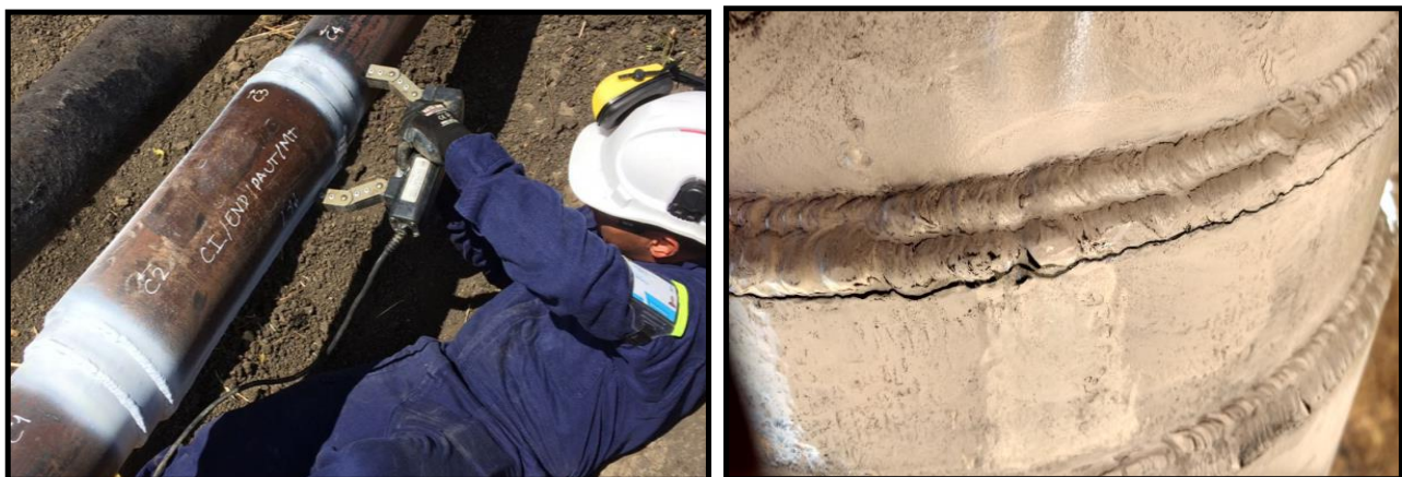
Figura 16.3. Aplicación del ensayo de partículas magnéticas
