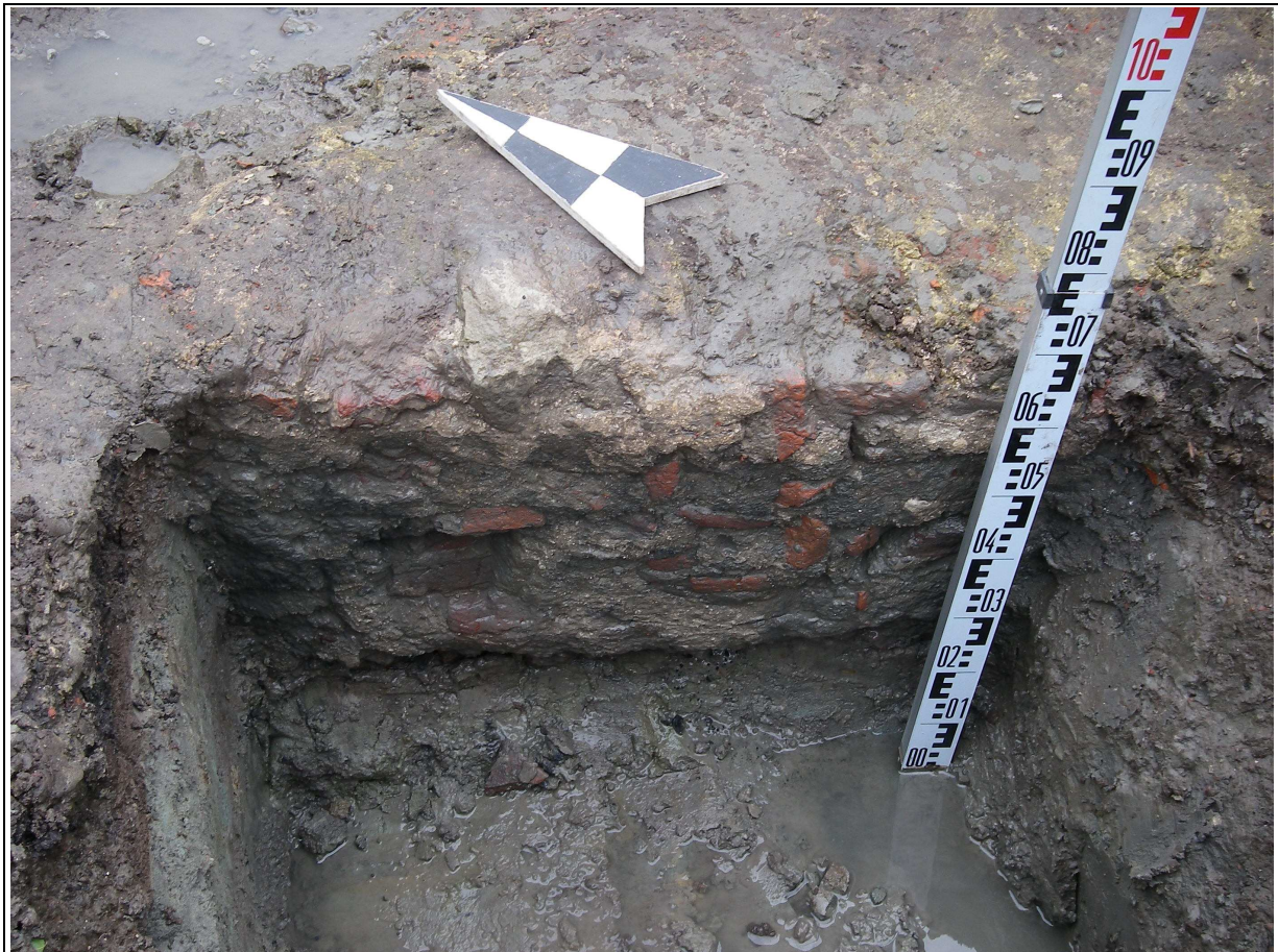
Fig. 12: Een dikke en slordig afgewerkte bakstenen muur die nog een hoogte van ca. 50 cm was bewaard, vormde vermoedelijk de fundering van een muur rond de pandgang van het klooster (bron: Dendermonds Archeologisch Team).
