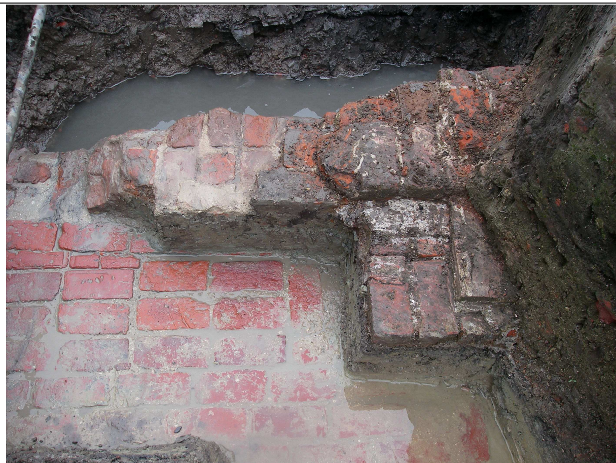
Fig. 14: De keldermuur kende in het noorden een uitsprong die was voorzien van vierkante tegels en die mogelijk de aanzet van een trap vormde (bron: Dendermonds Archeologisch Team).
