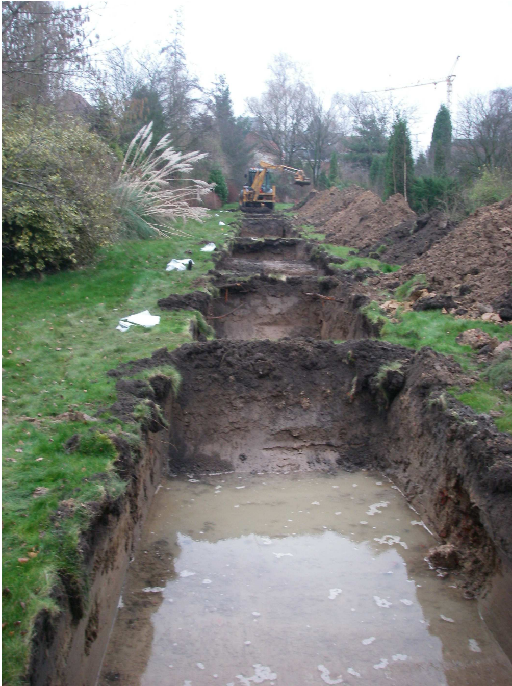
Fig. 1: De waterverzadigde ondergrond leverde tijdens de opgravingen stabiliteitsproblemen op (bron: Dendermonds Archeologisch Team).
