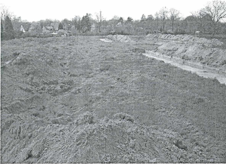
Fig. 2: Zicht op het perceel met enkele proefsleuven.
