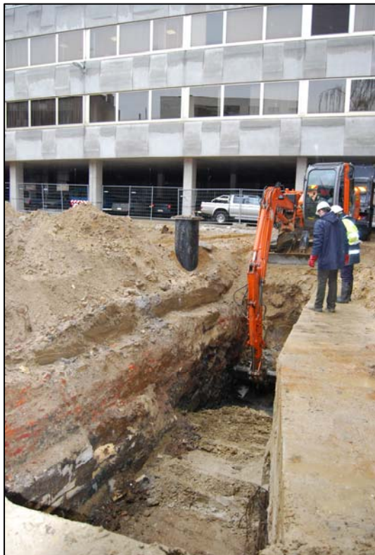
Fig. 17: Opvolging van de saneringswerken ten zuiden van buitenmuur S 109. De mergelmuur is op de voorgrond zichtbaar.
