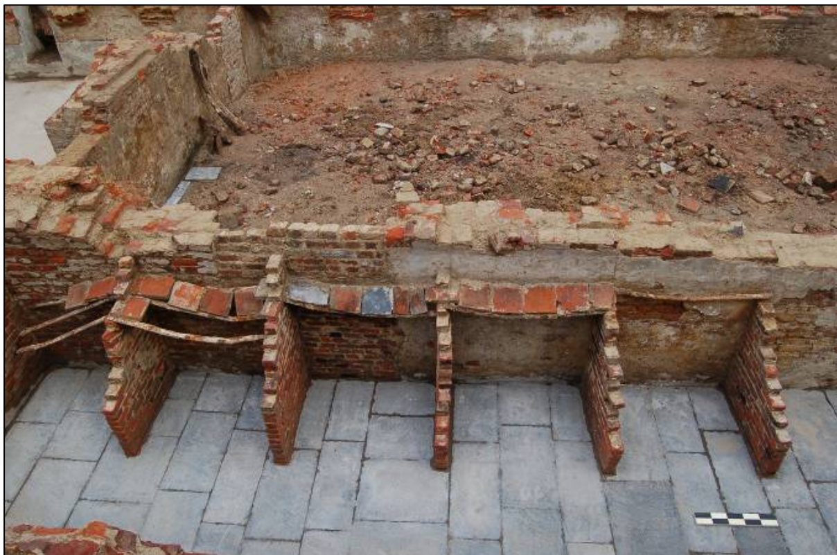
Fig. 23: De rekkenconstructie in de lange gang van gebouw 1.
