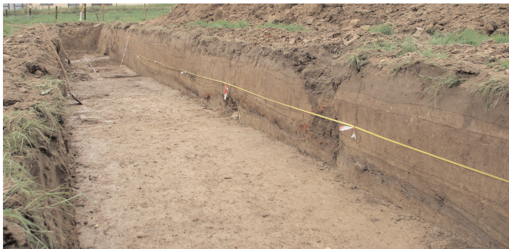
Afbeelding 12 : Sleuf 64, algemeen zicht op het op te graven rioleringstracé.
