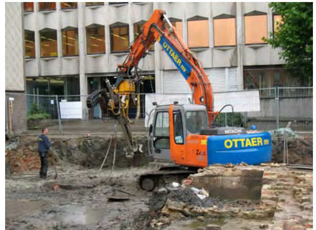
6. Plaatsen van de muurankers
