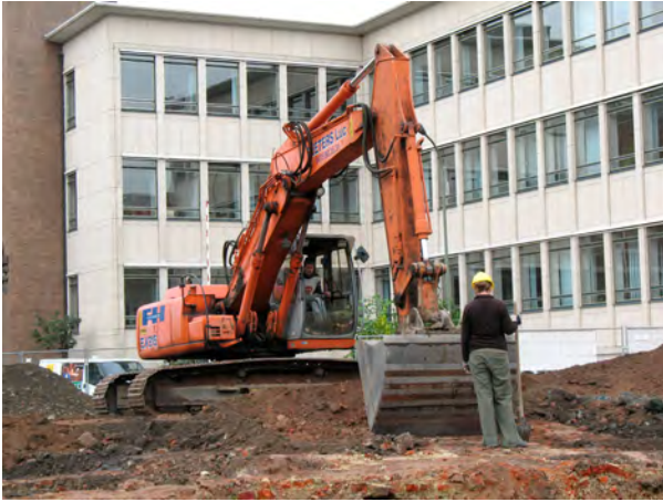
24. Afgraven van het terrein
