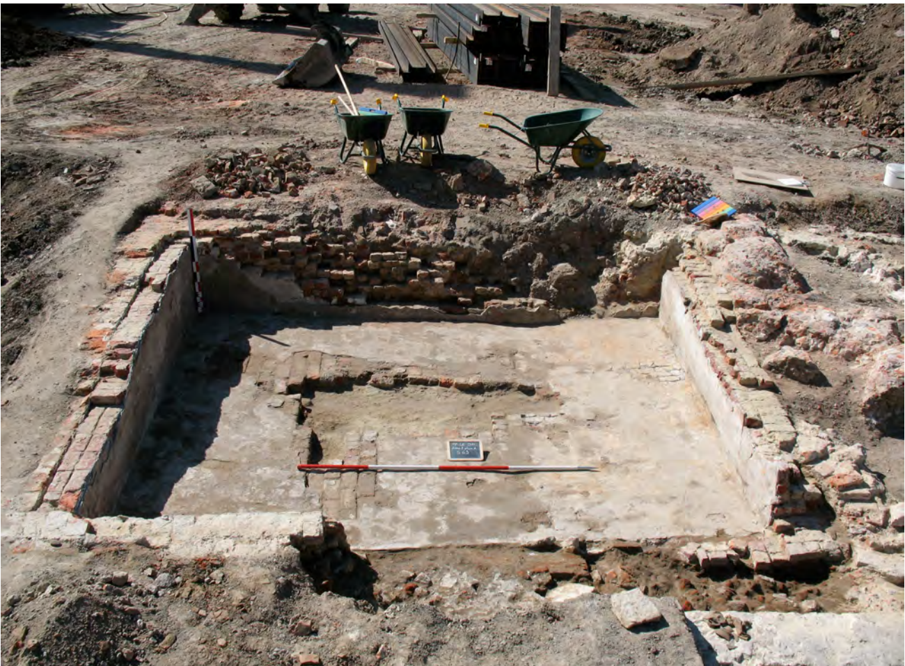
132. Kelder op perceel 241r
