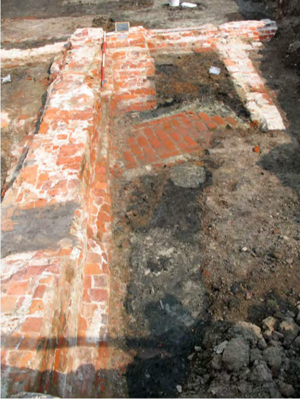
106. Restanten van woningen op het zuidwestelijk deel van het terrein
