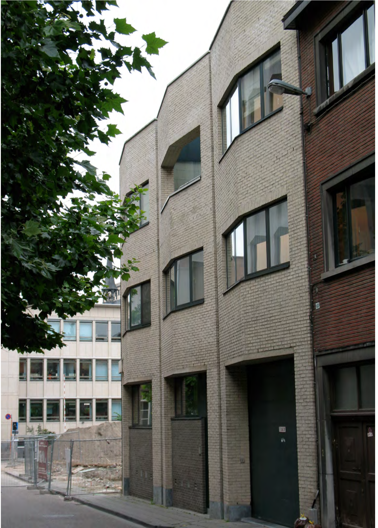
50. Sint-Barbarastraat vanuit het zuidoosten gezien, 2007
