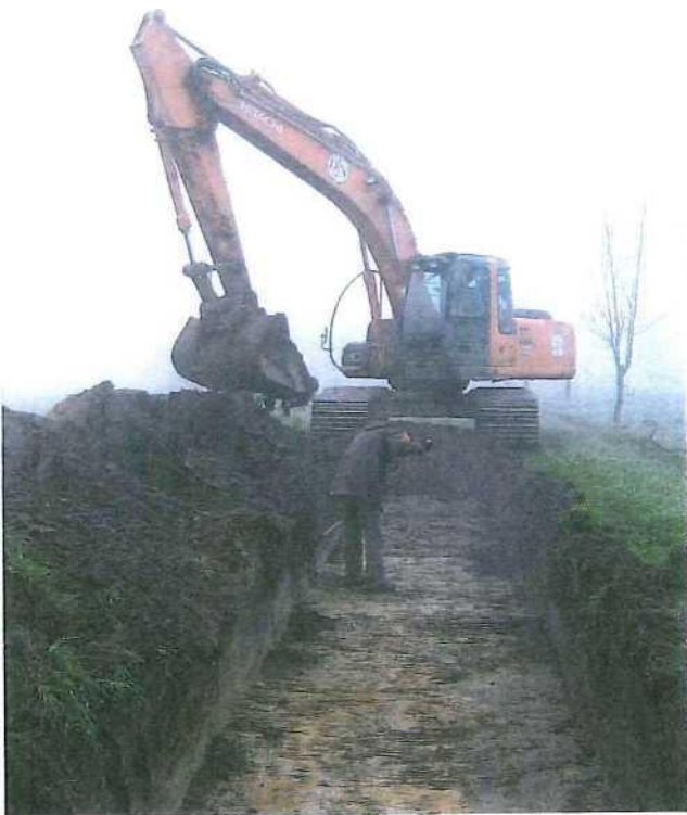
Figuur 13: Sfeerbeeld van de graafwerkzaamheden.
