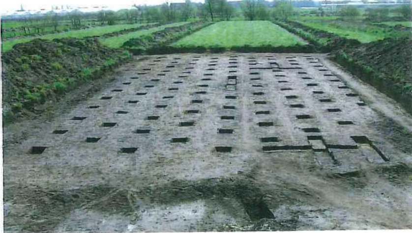
Figuur 37: Overzicht van de testvakken.
