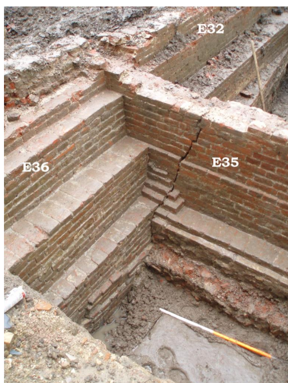
Figuur 39: Zicht op de versnijdingen in het gebouw uit fase 2, gezien vanuit het zuidoosten.
