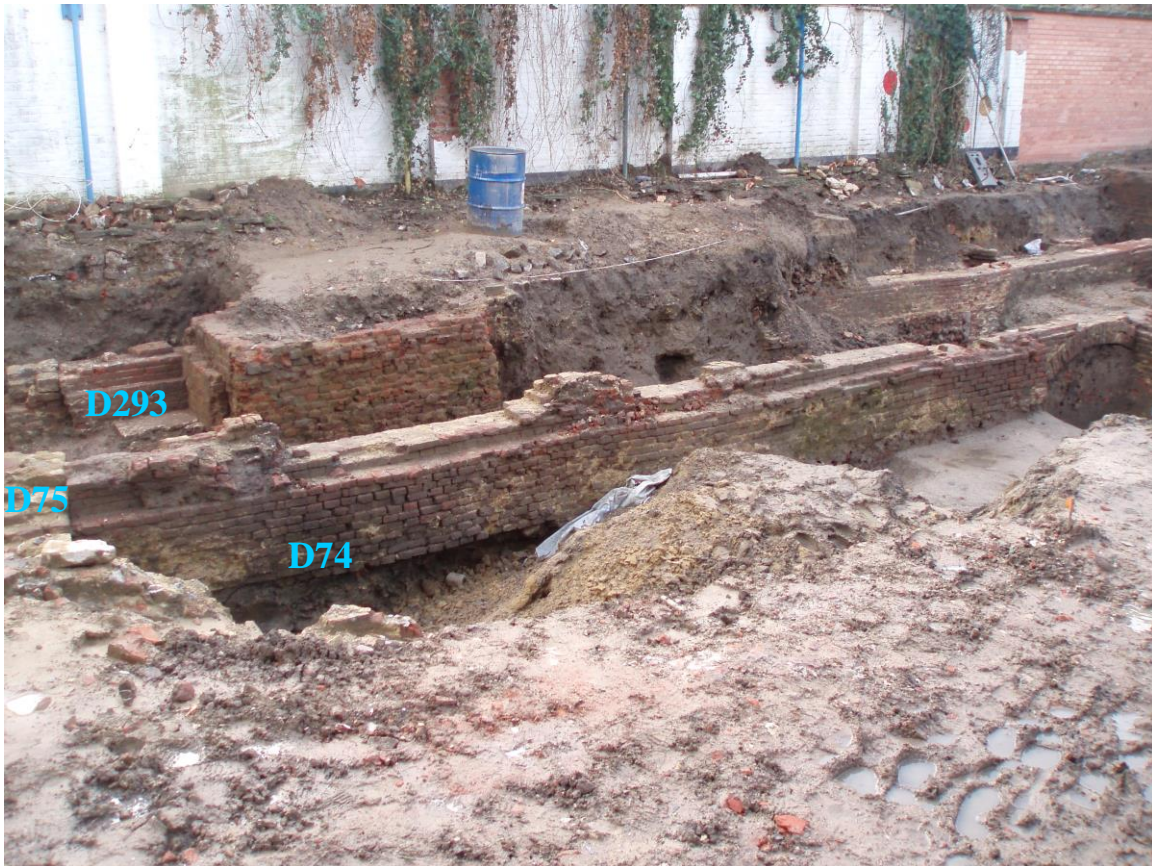
Figuur 27: Zicht vanuit het zuidoosten op de pandgang.
