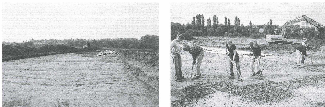
Fig. 25 en 26: Het opentrekken en het opschaven van het eerste opgravingsvlak op basis van sleuf XX.
