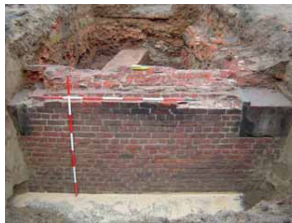
afb. 6: Kaaimuur S6 ter hoogte van sleuf 1, gezien vanuit het oosten: bovenaan links en vooral rechts zijn de natuurstenen blokken te vinden (B. Acke & R. Trommelmans)
