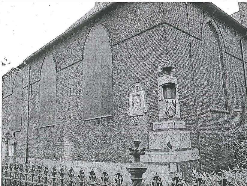
Figuur 35: Buitenmuur M 15 (foto B. Acke).
