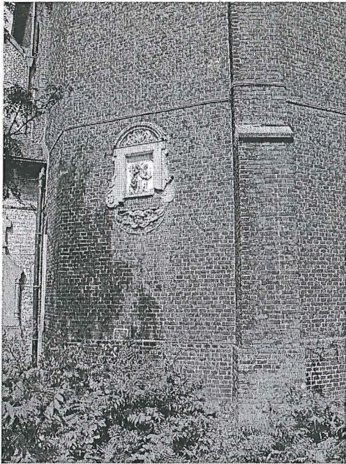
Figuur 27: Onderzijde buitenmuur 11 (foto B. Acke).
