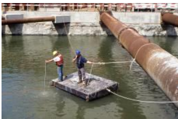
Fig. 45 Een duikteam toont de positie en hoogte aan van de houten structuur.
