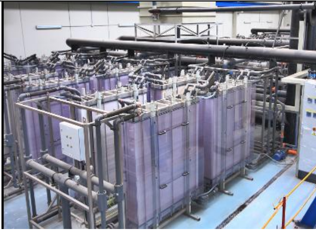
Рис. 5.12. Внешний вид электродиализной установки.
