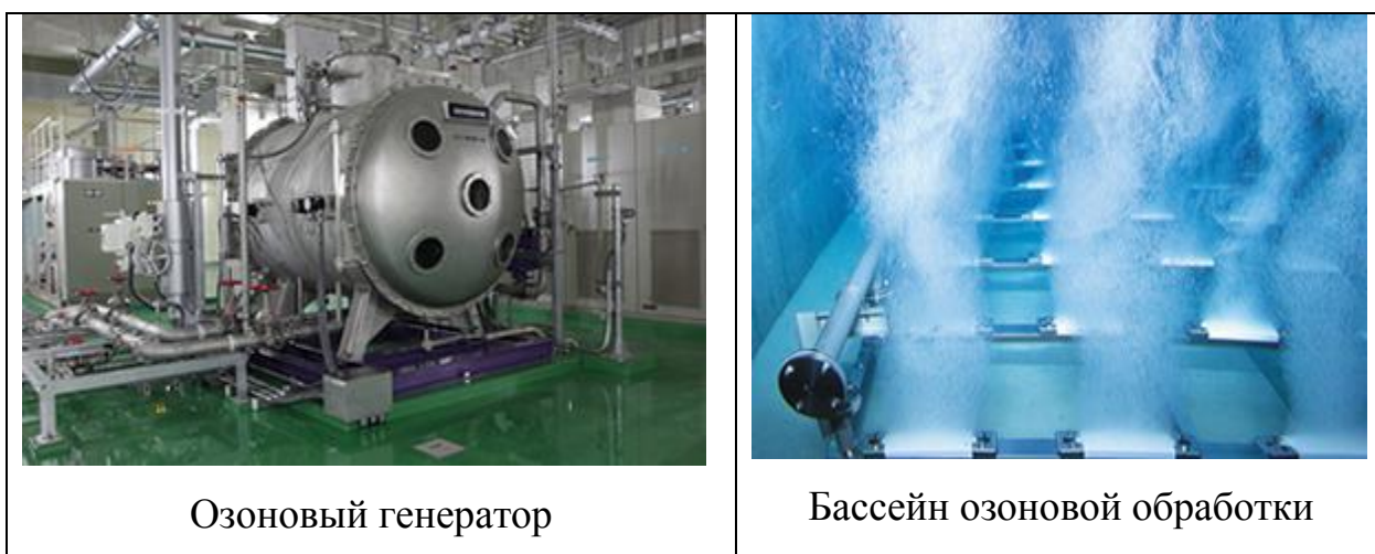
Рис. 5.27. Муниципальное правительство Токио использует для обработки воды озон, который является сильным оксидантом, способным разрушить практически все органические вещества, которые находятся в воде.
