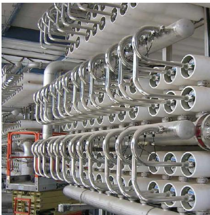
Рис.5.14. Фрагмент установки обратного осмоса. (Эль-Пасо, Техас, США).
