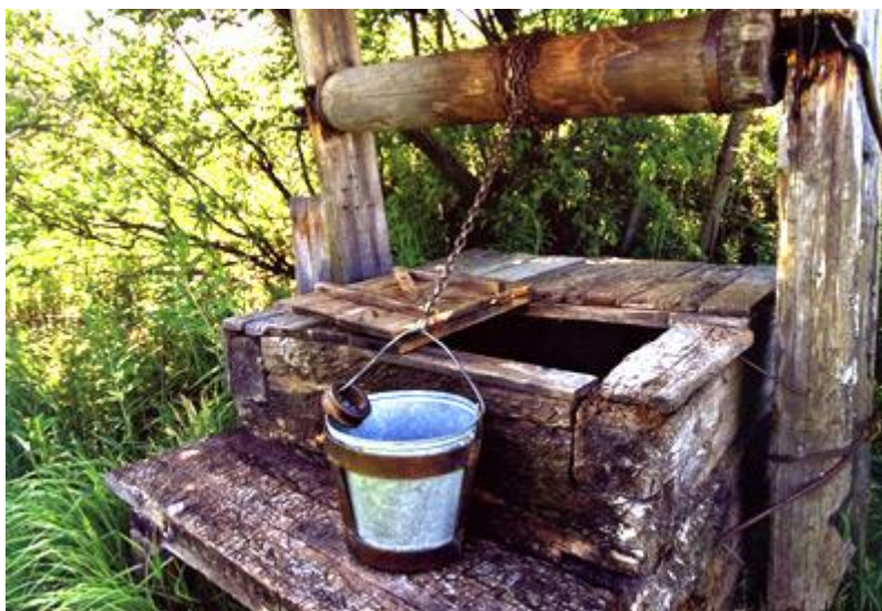
Рис. 5.24. Наиболее ярким и узнаваемым источником нецентрализованного водоснабжения является колодец - гидротехническое сооружение для добывания грунтовых вод, обычно представляющее собой вертикальное углубление с укрепленными стенками и механизм подъема воды на поверхность (в данном случае - ведро на цепи и ворот).
