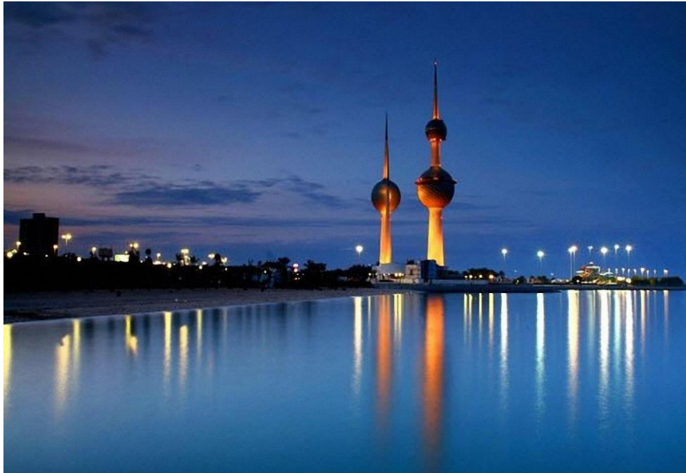
Рис. 5.28. Водонапорные башни из прочного железобетона призваны обеспечивать давление в водопроводных сетях города Эль-Кувейт и служат в качестве хранилища воды. Когда-то самая высокая из башен в своих двух шарах вмещала миллион галлонов воды (4,5 тыс. м 3 ) и обеспечивала ею все соседние районы. Сейчас башня как водонапорная не используется.
