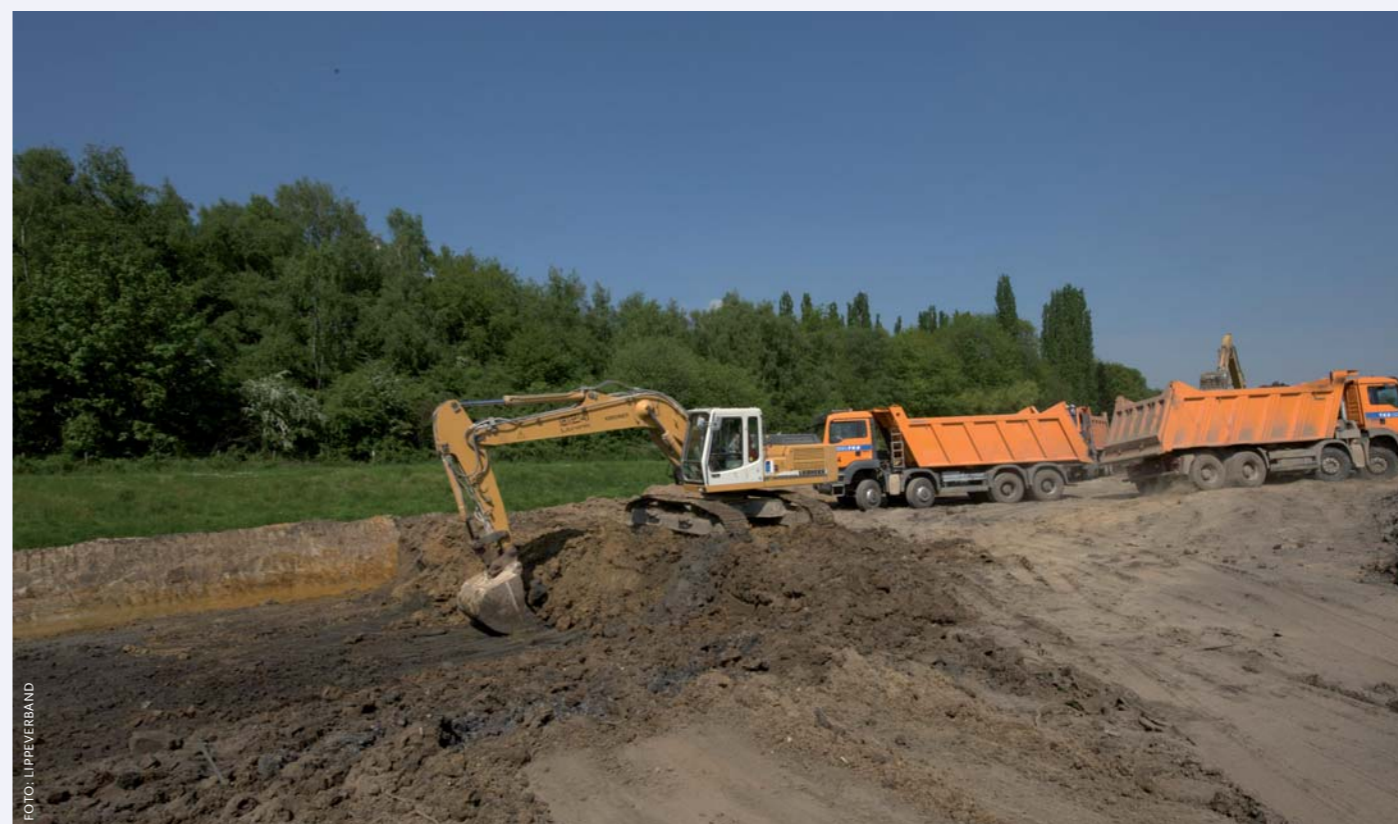
De Sekese ten oosten van Dortmund wordt dit jaar omgebouwd van afwateringskanaal tot natuurlijke rivier. De ICBR werkt al zestig jaar aan de duurzame ontwikkeling van de Rijn en zijn uiterwaarden en alle wateren in het stroomgebied.
