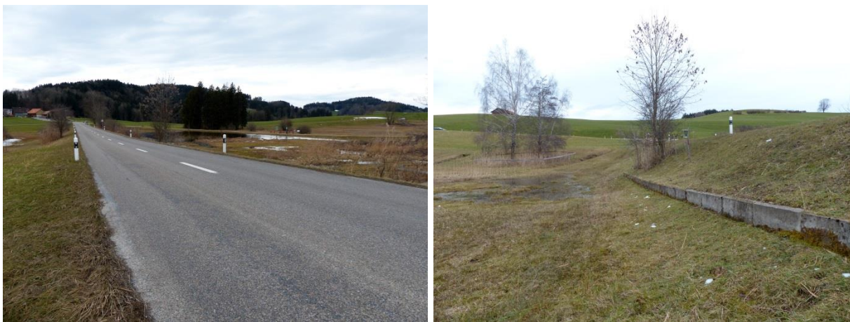
Abbildung 54, 55: Situation mit dem Amphibienlaichgewässer bei Kirchberg. Das Bild rechts zeigt die Anwanderseite von Süden mit dem Leitsystem unterhalb der Strassenböschung.
