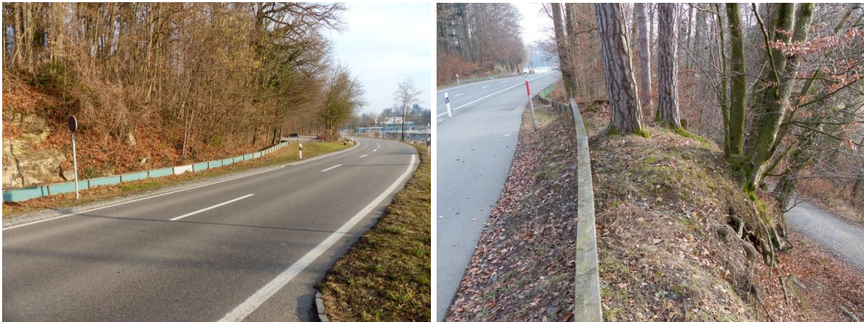
Abbildung 81, 82: Die Leiteinrichtung ist nach dem im Kanton Zürich verwendeten Typ ausgeführt, d.h. mit grünen Kunststofffolien, die mit Holzpflocken befestigt werden. Das Bild rechts zeigt den kleinen Abhang zwischen der Anwanderseite, der Strasse und dem Laichgebiet.
