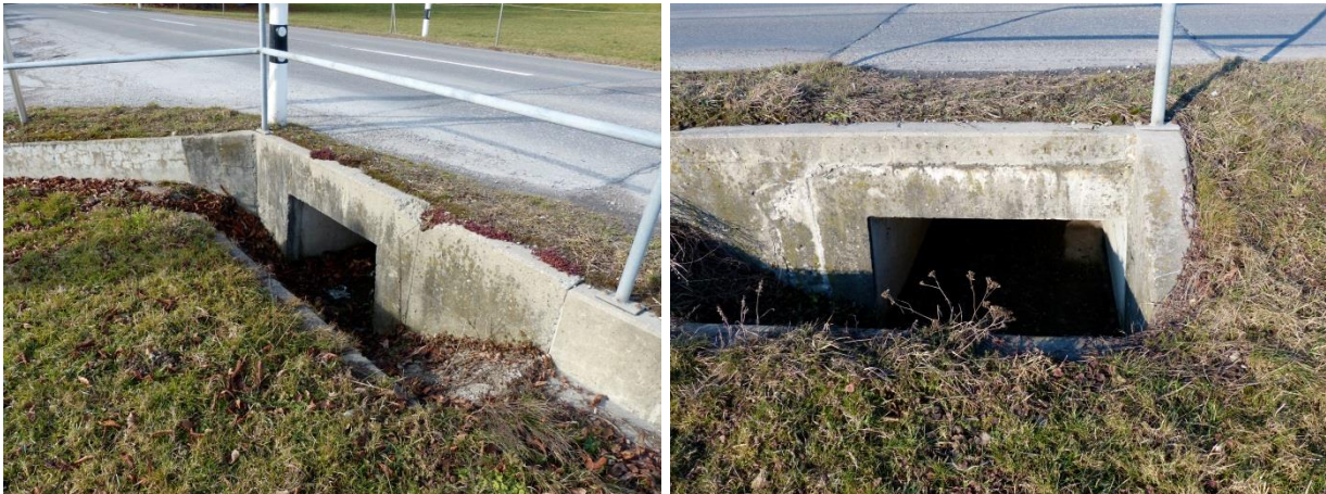
Abbildung 87, 88: Das Bildpaar zeigt Durchlässe auf der Rückwanderseite auf der keine Einweisungselemente eingerichtet wurden.
