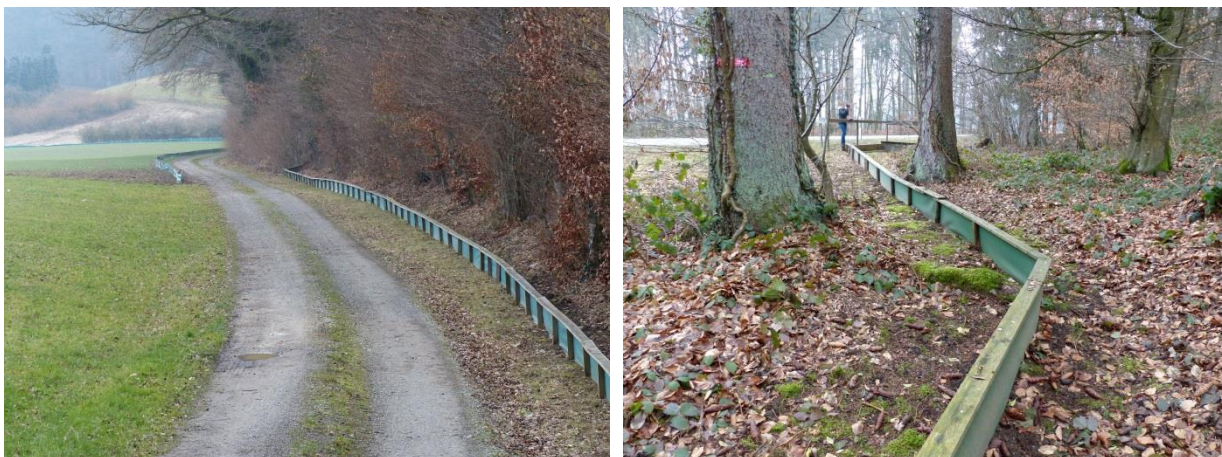
Abbildung 50, 51: Amphibienleitanlage bei Hochfelden. Das Bild links zeigt rechterhand des Weges den festen Teil der Leitanlage und linkerhand im Hintergrund einen mobilen Verlängerungsteil. Das Bild rechts zeigt den Verlauf im Waldgebiet mit den relativ grossen Lauflängen zwischen den einzelnen Tunnels.
