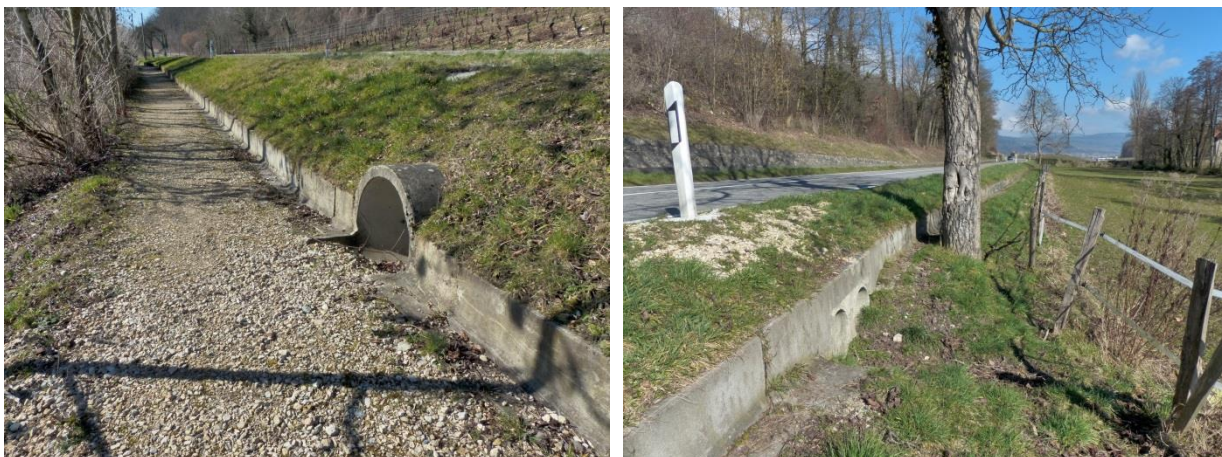
Abbildung 99, 100: Ansichten der seeseitigen Situation mit relativ langen Wegen der Amphibien bis zu den Durchlässen, die keine Einweisungselemente aufweisen.
