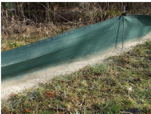
Abbildung 47: Mobiler Leitzaun, der ergänzend zu den Beton-Leitwerken jeweils installiert wird. Zu sehen ist der Sand, der zur Deckung und „Abdichtung“ des Folienzauns zur Bodenoberfläche verwendet wurde. Für die Haut der Amphibien kann der Sand schädlich sein.
