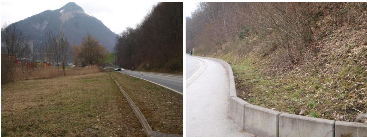
Abbildung 102, 103: Situation der Amphibienschutzanlage in Stansstad (Rotzloch) mit dem ersichtlichen steilen Hang der Anwanderung und den Leitwerken aus Beton.
