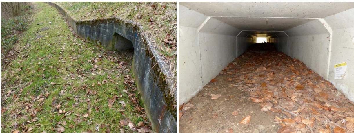
Abbildung 15, 16: Die Bilder zeigen einen Beispiel-Durchlass in Leuggern (links) mit gut gepflegten Laufflächen entlang der Leitwerke und im Durchlass selbst.
