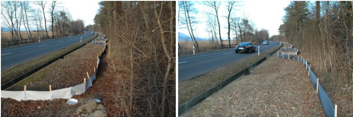
Abbildung 4, 5: Beispiel eines eingerichteten Anwanderzauns in Yvonand. Die Tiere, welche aus dem Waldgebiet am rechten Bildrand anwandern, treffen auf den Anwanderzaun und fallen in die eingegrabenen Eimer. Nach deren Zählung jeweils am Morgen werden die Tiere gleich auf der anderen Seite des Zaunes wieder freigelassen, so, dass sie in der nächsten Nacht ihre Wanderung durch die Leitanlage fortsetzen können. Im Zwischenbereich wurden – falls nicht ausreichend vorhanden – Bretter oder andere Unterschlupfmöglichkeiten für die Amphibien eingerichtet.
