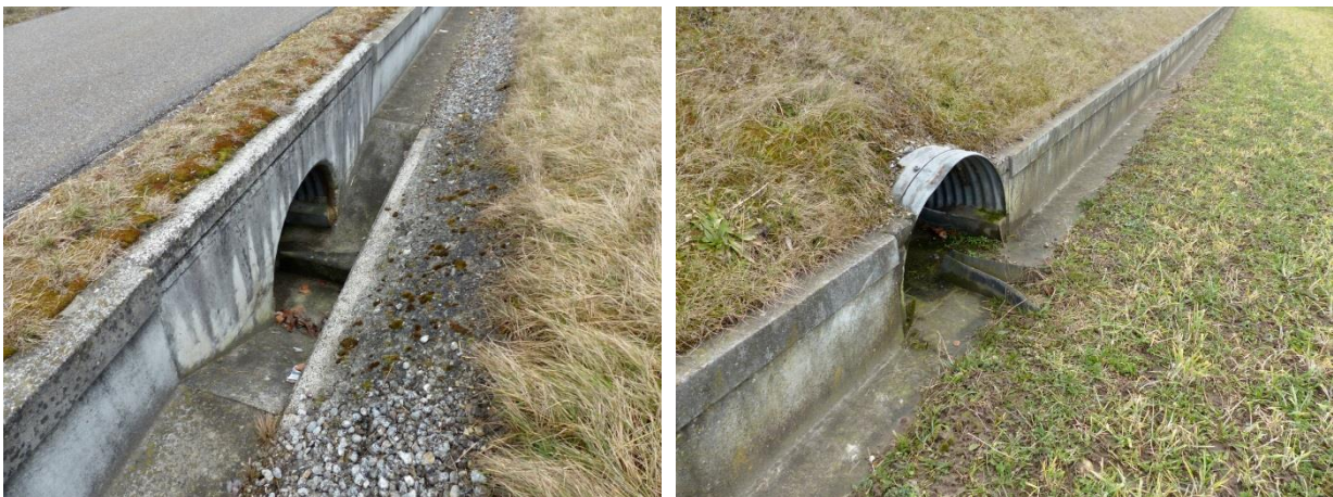
Abbildung 60, 61: Ansichten der Leitelemente aus Beton mit dem hangwärts gelegenen Waldgebiet als Sommerlebensraum der Amphibien. Die Amphibien-Schutzanlage konnte im Zuge der Realisierung des im Bild sichtbaren Velowegs erstellt werden.
