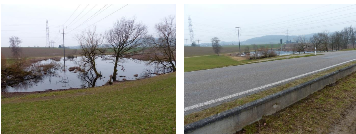
Abbildung 48, 49: Amphibienlaichgewässer Stadlersee bei Hochfelden, Bild links. Das Bild rechts zeigt die Stadlerstrasse mit der Umgebung und der Leitanlage im Vordergrund, welche die Tiere aus dem Purenholz kommend vor einem vorzeitigen Queren der Strasse schützt und zu den auf der Höhe des Sees liegenden beiden Tunnel führt.
