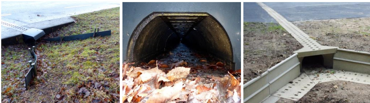
Abbildung 6-8: Aco-Tunnel beim Standort Bleienbach mit Einweisungselementen (links). Die Leitwerke bei der Anlage in Bleienbach werden jeweils während der Laichwanderung mit mobilen Maibachzäunen errichtet, welche hier auf dem Bild noch nicht eingerichtet sind. Das Bild in der Mitte zeigt den Lichteinfall und die feuchte Lauffläche im Innere des Tunnels. Das Bild rechts zeigt eine Standardeinrichtung mit trichterförmiger, idealer Zuweisung zum Eingang des Durchlasses.
