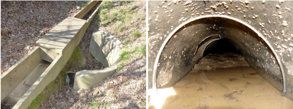
Abbildung 93, 94: Das Bildpaar zeigt den überdeckten Bereich des Einfallschachtes im Einweg-Durchlass-System. Darunter ist der Ausgang zu erkennen, des von der gegenüberliegenden Strassenseite zuführenden Durchlasses. Das Bild rechts zeigt einen im Eingangsbereich überfluteten Durchlass.
