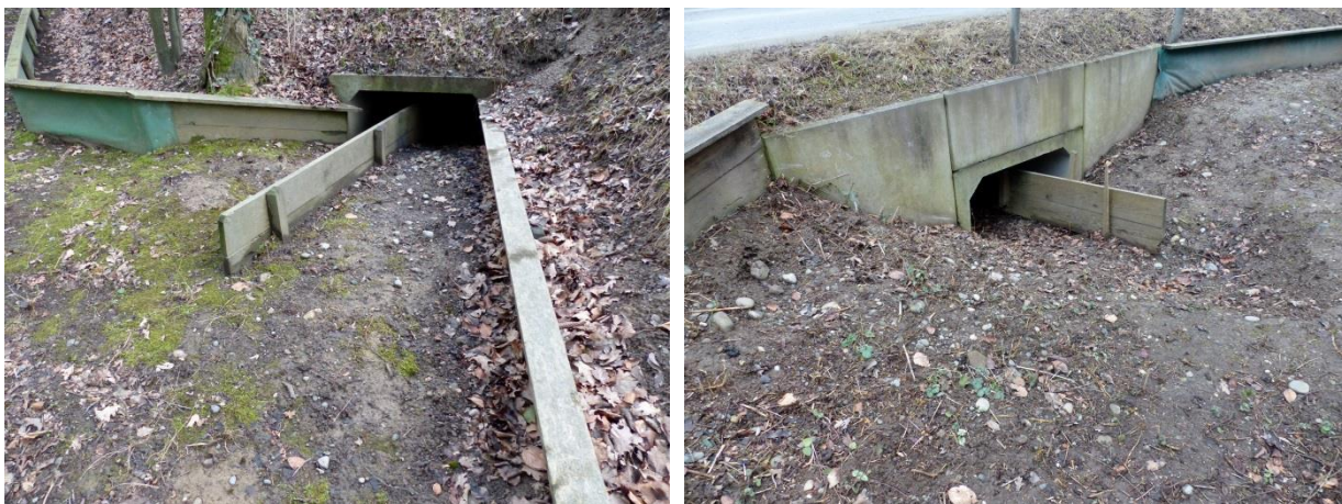
Abbildung 52, 53: Ein- (linkes Bild) und Ausgangsbereiche (rechtes Bild) der Amphibiendurchlässe mit den Einweisungselementen.
