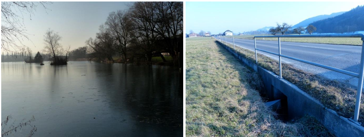
Abbildung 85, 86: Das Bildpaar zeigt den Bettenauerweiher und die nördlich davon gelegene Kantonsstrasse mit der Leitanlage. Zu sehen ist ein Einschnitt zur Führung der Amphibien auf die Ebene des Durchlasses mit dem Einweisungselement.
