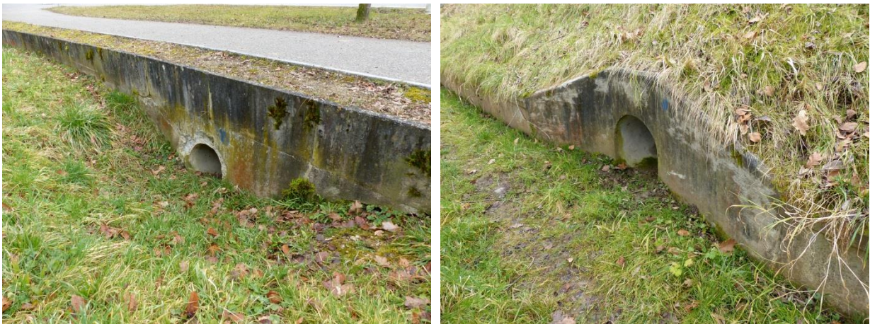
Abbildung 69, 70: Zu erkennen ist der zweite Durchlass-Typ mit runden Röhren im Vergleich zu den Kastenprofil-Durchlässen (Abb. 31). Seeseitig sind die Leitsysteme leicht trichterförmig.
