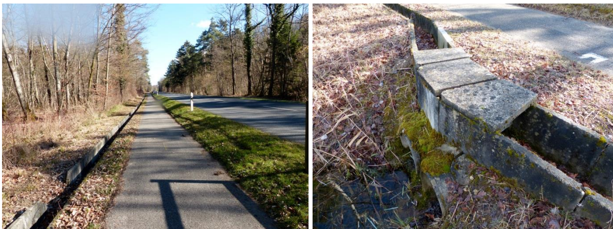
Abbildung 110, 111: Ansicht des Sammelkanals (links) mit Ausstiegsmöglichkeit durch Unterbrechung des Kanals seeseitig. Rechts zu sehen ist der abgedeckte Einfallschacht für die Amphibien und die darunterliegenden Durchlässe.
