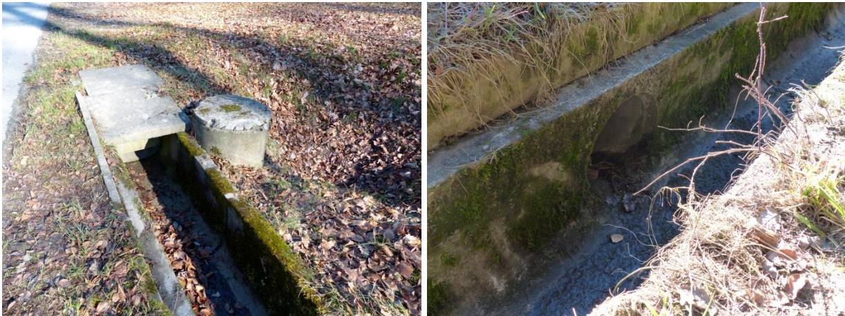
Abbildungen 35, 36: Sammelkanal mit Fallschacht und Sichtblende (Foto links) (Tunnel C, s. Karte) sowie zusätzlicher Eingang eines Durchlasses (Foto rechts) (Tunnel B, s. Karte).
