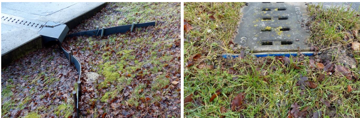
Abbildungen 30, 31: Amphibien-Durchlass mit Einweisungselement bei der Leitanlage. Im Bild nicht zu sehen sind die jeweils während der Laichwanderung installierten Leitzäune (Typ Maibach), welche verbindend zwischen den Durchlässen montiert werden. Bild rechts zeigt wie die Tunnelausgänge nach der Laichwanderung verschlossen werden zur besseren Bearbeitbarkeit des landwirtschaftlichen Geländes.
