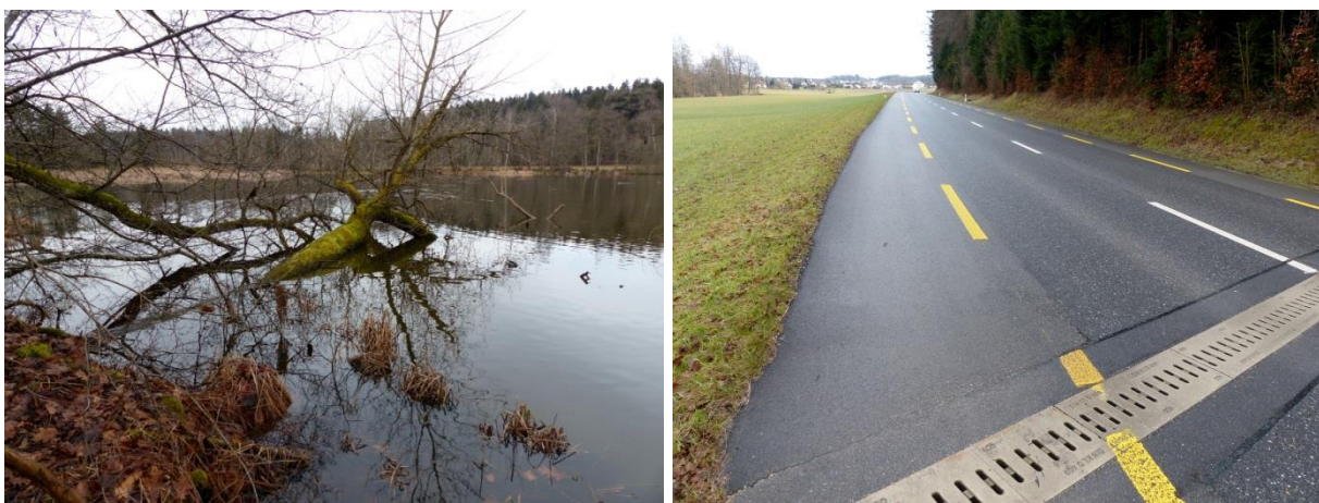
Abbildungen 28, 29: Situation des Laichgewässers Torfsee mit der Kantonsstrasse zwischen Bleienbach und Langenthal. Im Vordergrund ist der eingebaute Aco-Tunnel zu sehen, rechts am Bildrand das Waldgebiet aus dem die Amphibien anwandern.
