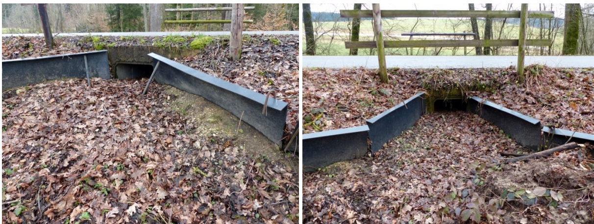
Abbildungen 27, 28: Amphibien-Durchlass und Leitwerk beim Amphibienlaichgewässer in Balzenwil. Zu erkennen sind die Kunststoffplatten, die jedes Jahr vor der Amphibienwanderung neu gerichtet werden. Die Führung der Platten zum Durchlass ist ideal trichterförmig.
