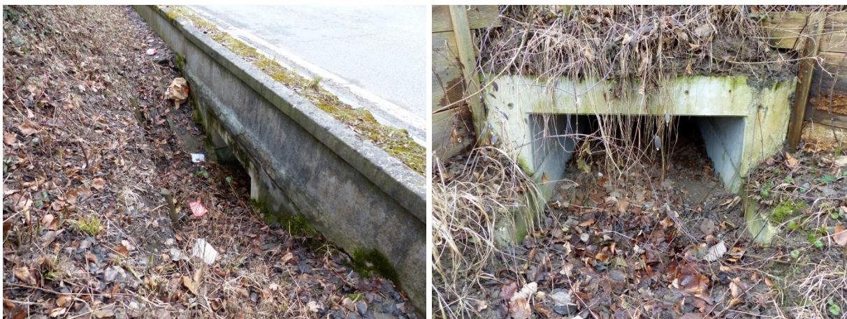
Abbildung 43, 44: Situation links mit Eingangsbereich, abgesenkt und Ausgangsbereich (rechtes Bild).
