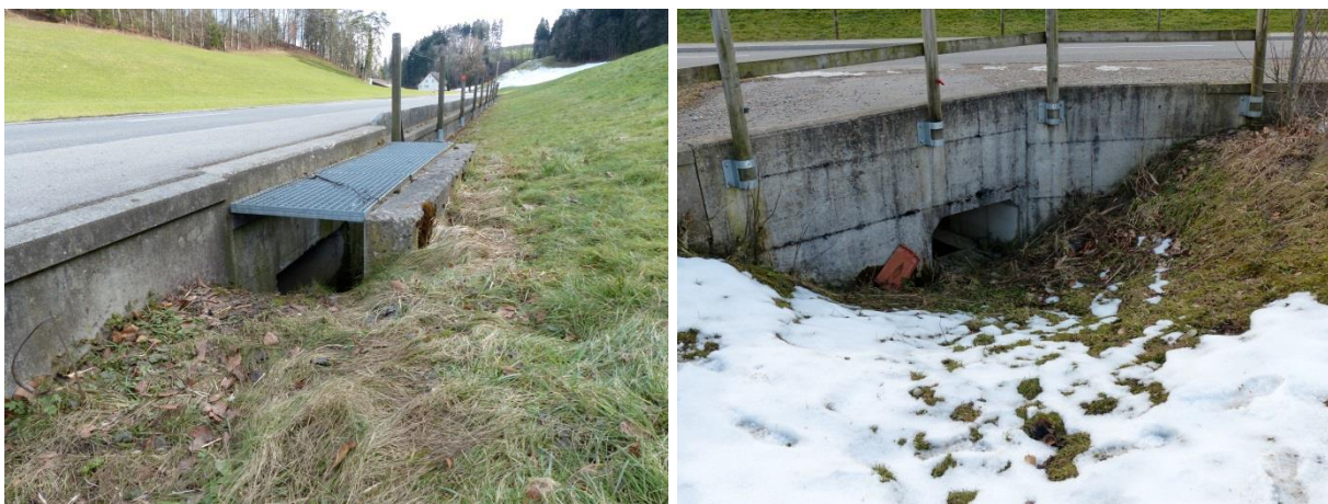
Abbildung 73, 74: Zu erkennen ist der zweite Durchlass-Typ mit runden Röhren im Vergleich zu den Kastenprofil-Durchlässen (Abb. 31). Seeseitig sind die Leitsysteme leicht trichterförmig.
