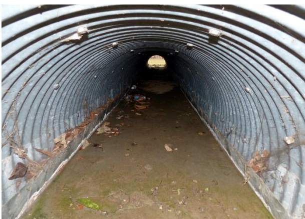
Abbildung 62-64: Situation der Tunnelein- (linkes Bild) und ausgänge (rechtes Bild) mit den Einweisungselementen und de relativ breiten Durchlässen. Das untere Bild zeigt die Lauffläche aus Beton, die teilweise eingeschwemmtes Material (Erde) enthält.
