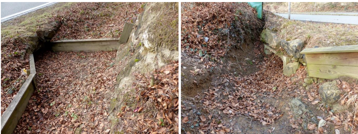
Abbildung 83, 84: Die Tunneleingänge sind trichterförmig ausgestaltet. Das Bild rechts zeigt, dass die ganze Leitanlage im Gelände teilweise schwierig so einzurichten ist, dass die Tiere nicht Möglichkeiten zum Überklettern haben.
