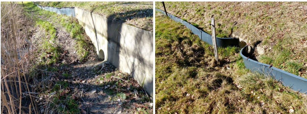
Abbildungen 37-39: Verschiedene Ausgänge von Einweg-Durchlässen von der Rückwanderseite her. Teilweise sind die Leitwerk-Platten trichterförmig installiert (Abb. 37, Tunnel B, siehe Karte). Einige Durchgänge scheinen für die Führung der Rückwanderung der adulten sowie juvenilen Amphibien ungeeignet.
