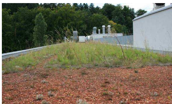
Abbildung 19-20: Versuchsdachbegrünung TUWAG (Wädenswil). Auf die bestehende Dachbegrünung wurde im Jahr 2007 Schnittgut aus­gebracht, welches von der Dachbegrünung auf dem Seewasserwerk Moos gewonnen werden konnte. Die oberen Bilder zeigen den unter­schiedlichen Bewuchs auf verschieden dick auf­getragenen Mulchschichten, von links nach rechts wurde jeweils mehr aufgetragen. Das untere Bild zeigt grundsätzlich den deutlichen Gewinn an Vegetationsbiomasse im Vergleich zur un­behandelten Fläche. Foto: D. Tausendpfund
