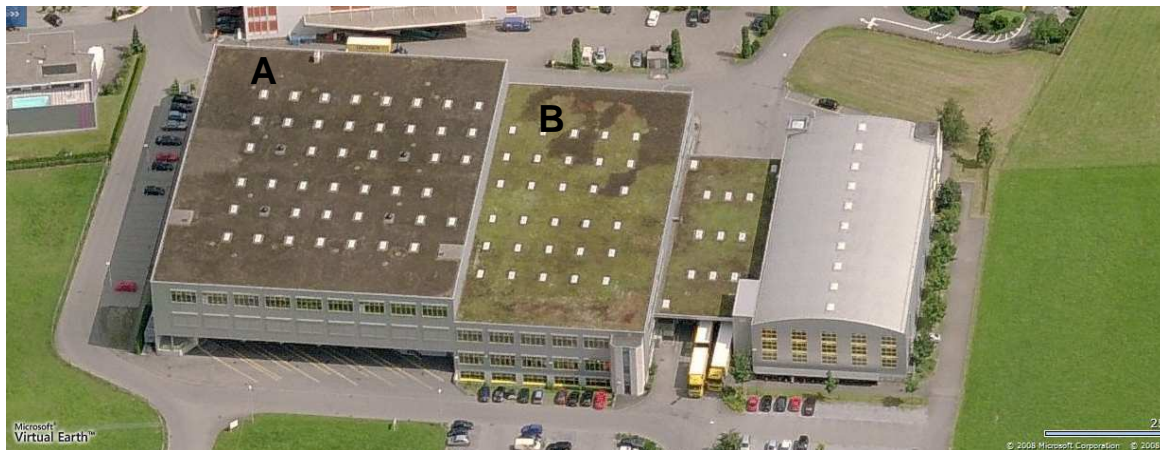
Abbildung 16: Das ALSO-Gebäudes in Emmen mit Kiebitzbruten. Kiebitzbruten fanden jeweils Eine auf dem Dach A und B statt. Auf der Luftaufnahme im Frühjahr ist zu erkennen, dass auf dem Gebäudeteil A kaum Vegetation vorhanden ist. Die erfolgreiche Aufzucht gelang auf dem Dach B mit deutlich erkennbarem Bewuchs. Auf dem Bild ist weiter der Gebäudeabsatz zu erkennen, welcher auf die Dachfläche B einen Schatten bewirkt. Quelle: Visual Earth, www.maps-live.com
