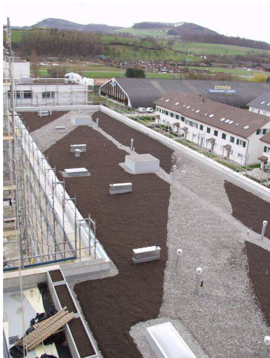
Abbildung 10: Dachbegrünung gestaltet als Ersatzhabitat für ehemalige kiesig sandige Flusssufer. Überbauung Römergarten Kaiseraugst, 1. Bauetappe. Foto: Stephan Brenneisen
