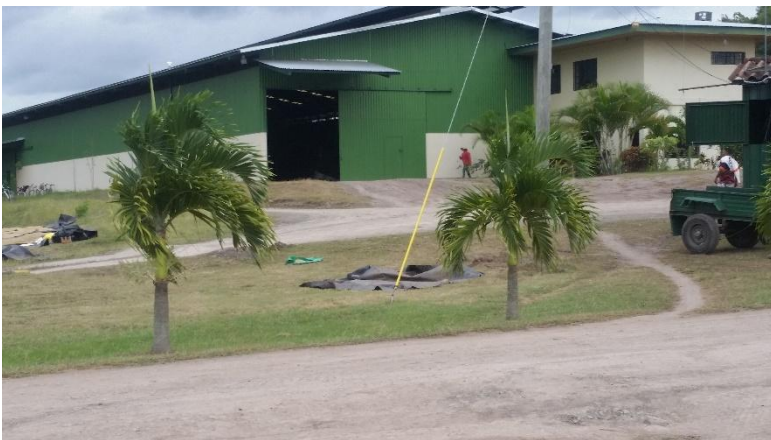
Instalaciones de beneficio seco PRODECOOP R.L. Palacagüina
