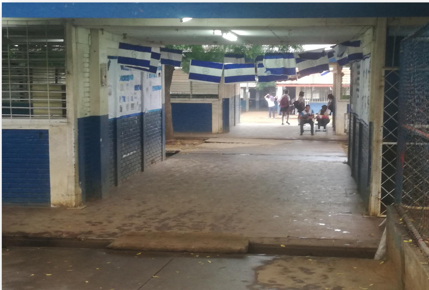
Pasillos al área de Secundaria
