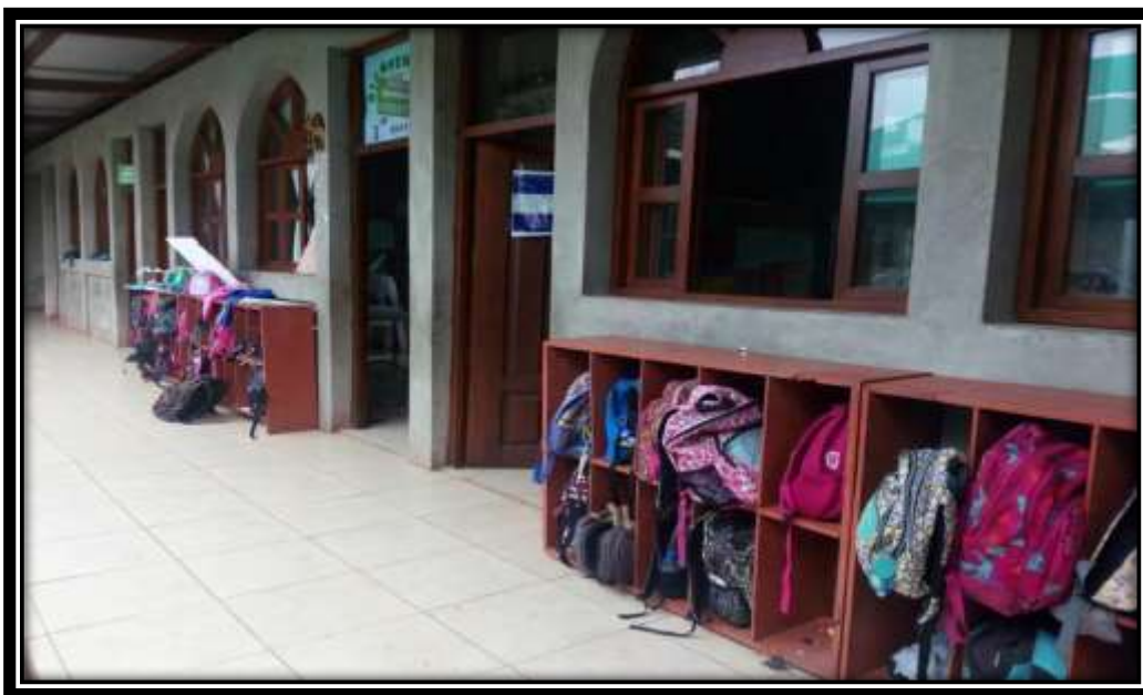
Foto # 2 Pabellón de Primaria
