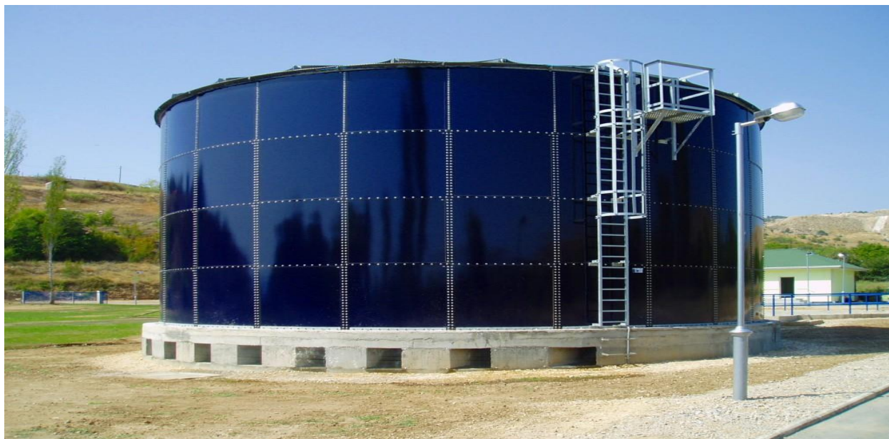
Fuente: ENACAL - ACOYAPA 2016. Tanque de almacenamiento del nuevo sistema de agua en Acoyapa, ubicado en el cerro el Jobo.
