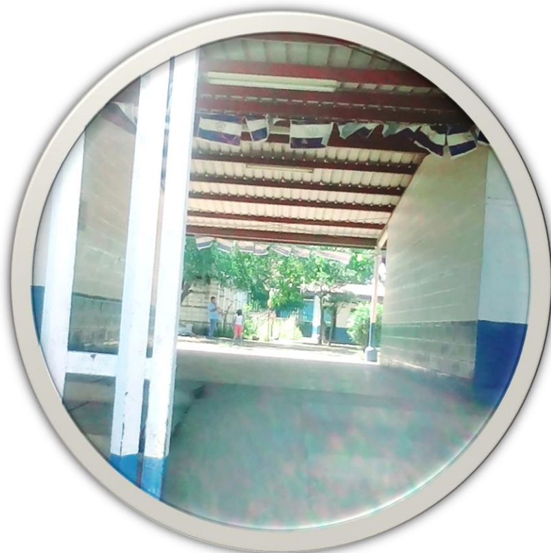
Entrada principal del centro
