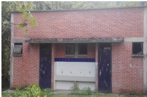
Figura 88. Aparejo de muro en soga
