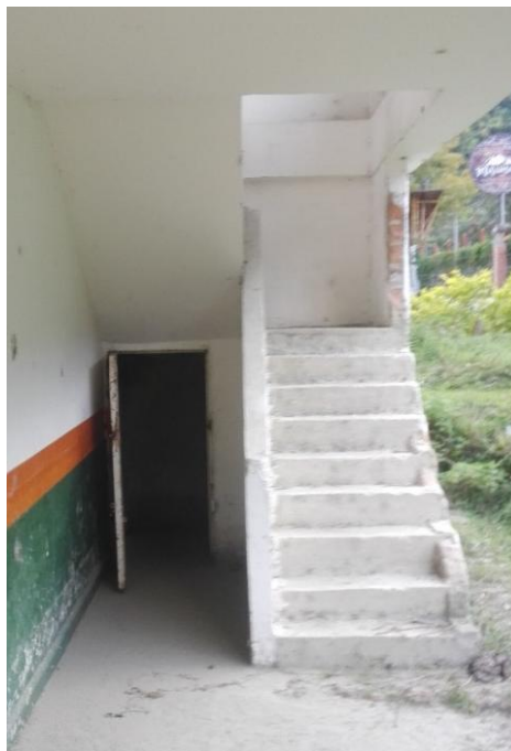
Figura 86. Escalera de concreto armado inmueble
