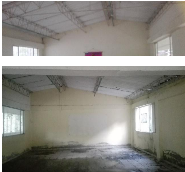
Figura 96. Fotografías tejas y estructura tipo cercha segundo nivel
