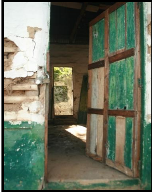
Figura 7 Interior de casa de bahareque.
