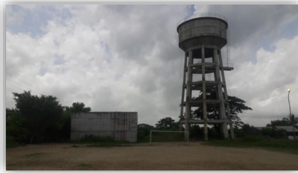
Figura 12 Tanques elevado norte y centro y tanque semienterrado zona norte.
