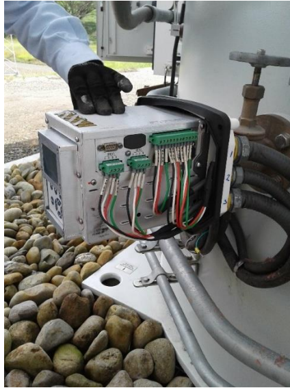
Imagen 66. Momento de la instalación del dispositivo con respecto a los planos de ingeniería.
