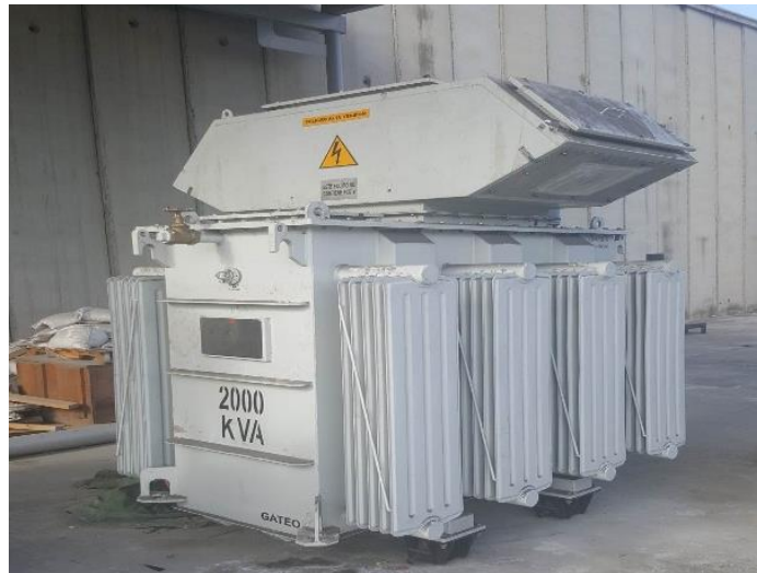
Imagen 54. Transformador 200 kVA Peña Colorada.
