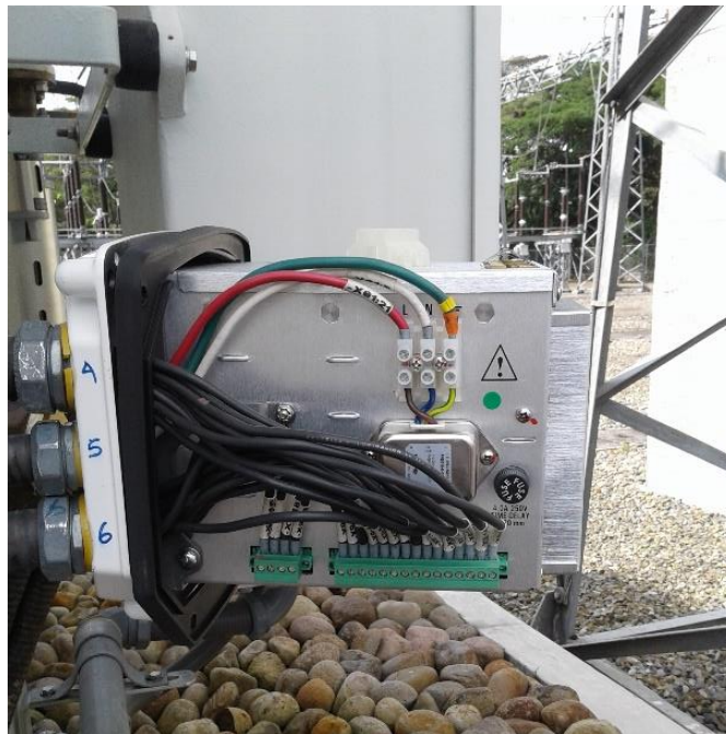
Imagen 65. Momento de la instalación del dispositivo con respecto a los planos de ingeniería.
