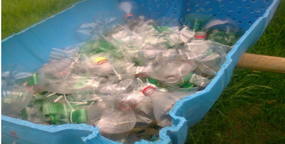
Figura 16. Conformación del medio filtrante del humedal.
