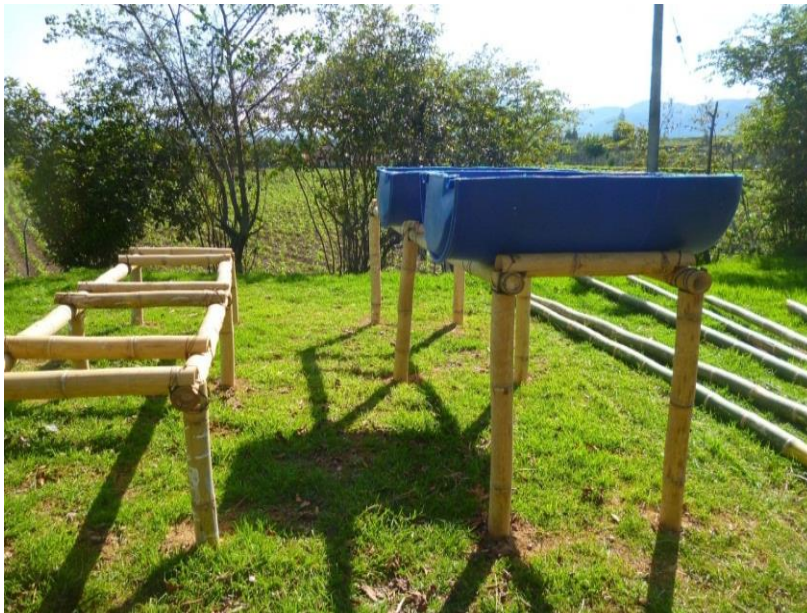
Figura 5. Estructura inicial de los humedales artificiales
