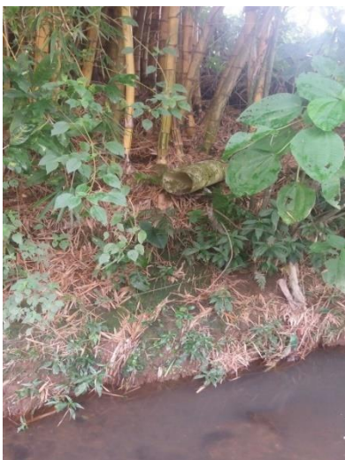
Foto 6. Tercer vertimiento a la quebrada Cañaverál
