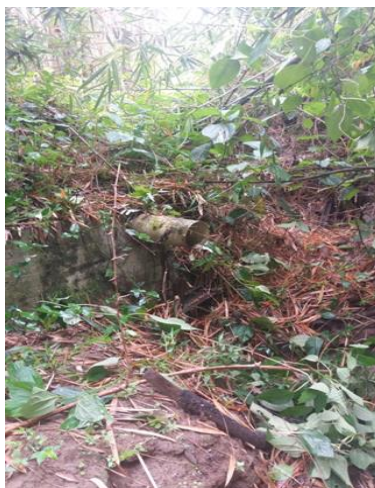
Foto 5. Segundo Afluente de Aguas Lluvias
