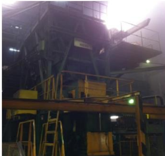
Figura 52 Instalação de areias GF (A. M. M. Almeida, 2014)
