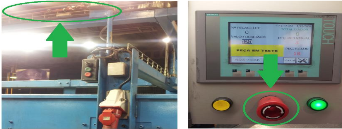
Figura 97 Cordel para bloqueio de linha e betoneira para bloqueio do posto
