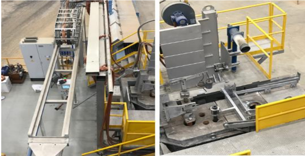
Figura 49 Plataforma de vazamento manual
