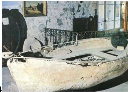
Figura 2.1- Primeira construção em betão armado, 1848 (Appleton, 2017).
