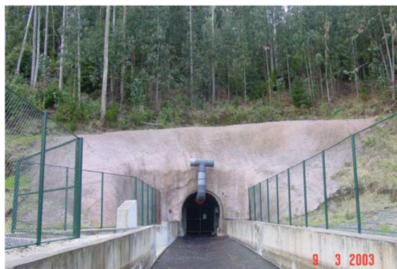
Figura 102 - Galeria de captação da Fajã da Ama, S. Vicente, Madeira (ARM, 2018).
