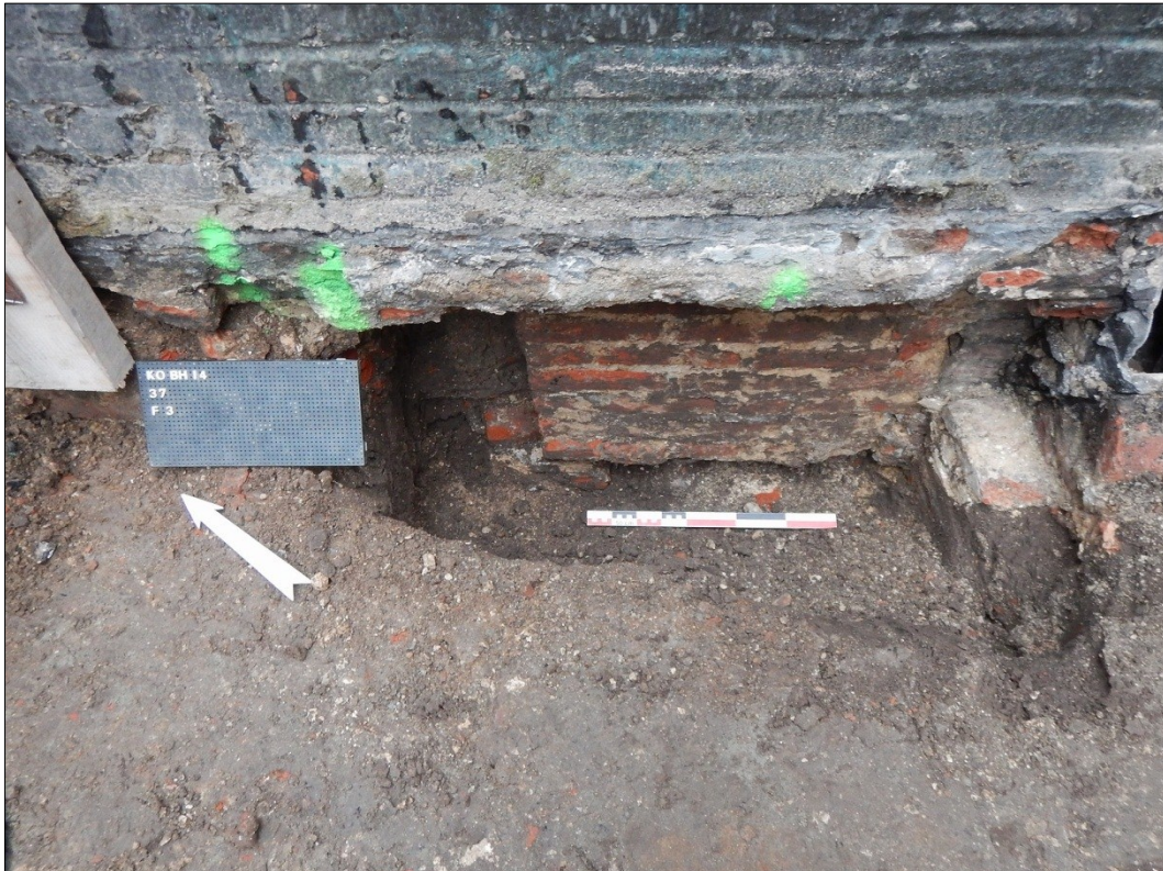
Figuur 40. In de funderingsleuf kon de hoek van de kelder onder de aanbouw waargenomen worden.
