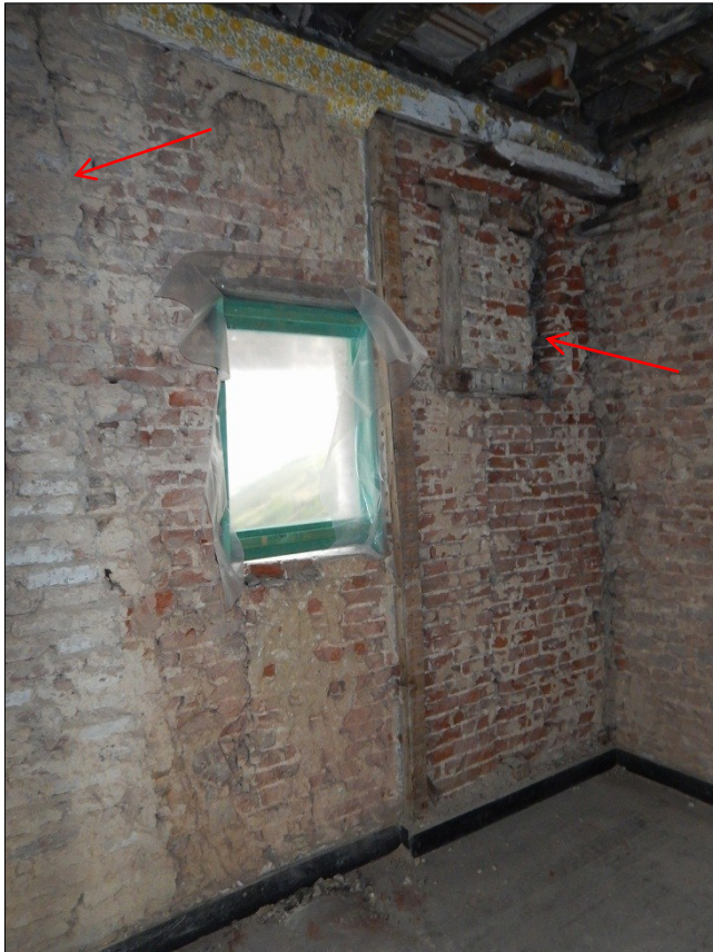
Figuur 9. Het hoog gepositioneerde dichtgemetselde raam in kamer 37-5 (rechts) en de bouwnaad van de schouw (links).
