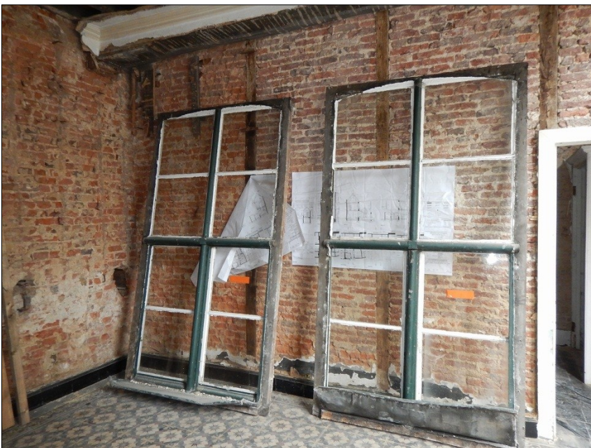
Figuur 17. De vakwerkbouw tussen kamer 39-3 en 39-4.
