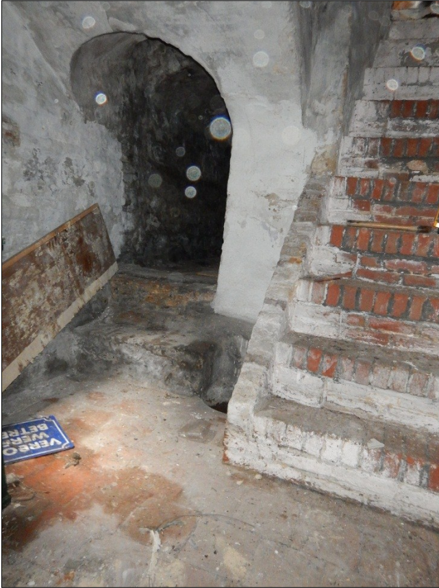
Figuur 18. De doorgang tussen kelder A en kelder B, waarbij het niveauverschil duidelijk merkbaar is.
