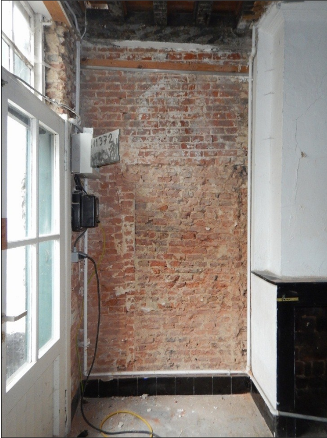
Figuur 25. Het bouwspoor van de deuropening in kamer 40-3.
