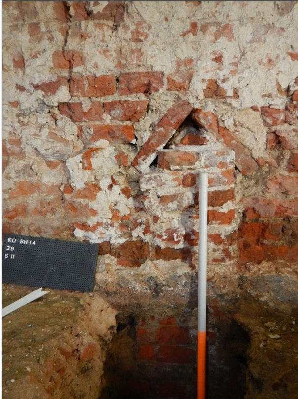
Figuur 69. In de achtermuur werd een dichtgemetselde nis aangetroffen.
