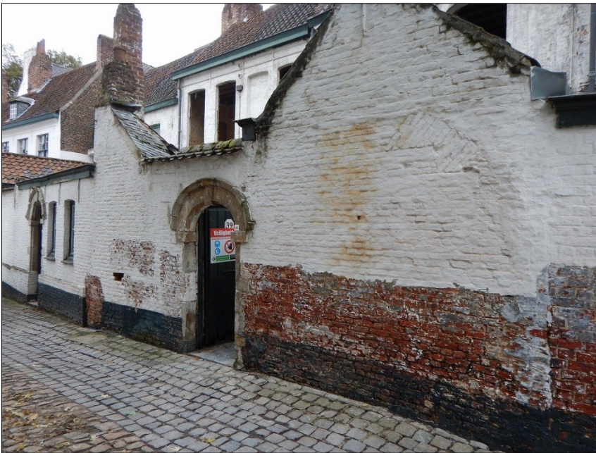
Figuur 16. De bouwnaad van het oudere dak in de straatgevel van kamer 39-2.
