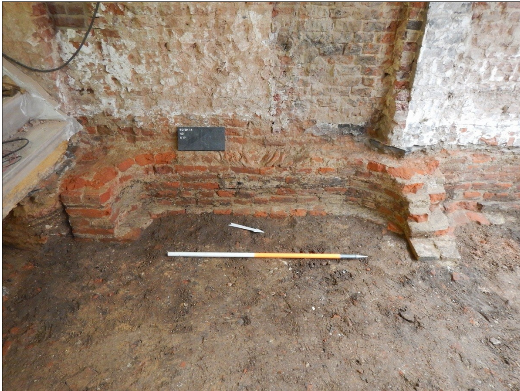
Figuur 83. De fundering van de haard tegen de westelijke muur.
