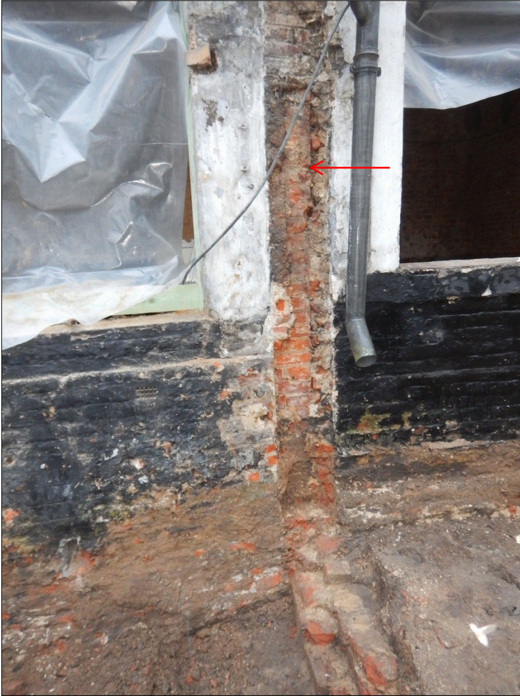
Figuur 54. Bij de afbraak van muur S18 kon de oorspronkelijk hoek van huis nr. 38 duidelijk vastgesteld worden
