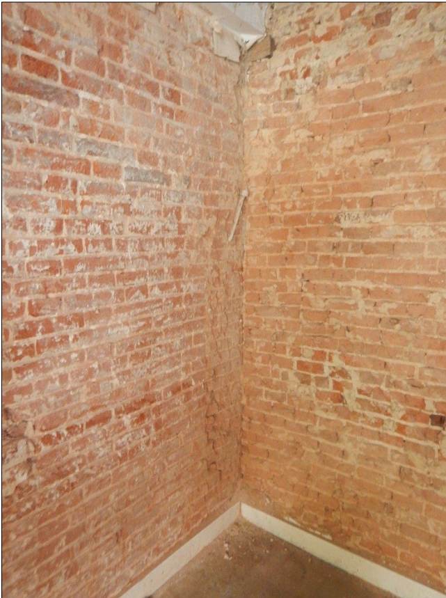
Figuur 26. Het gevelanker in kamer 40-5, dat zich gedeeltelijk achter de achtermuur bevindt.
