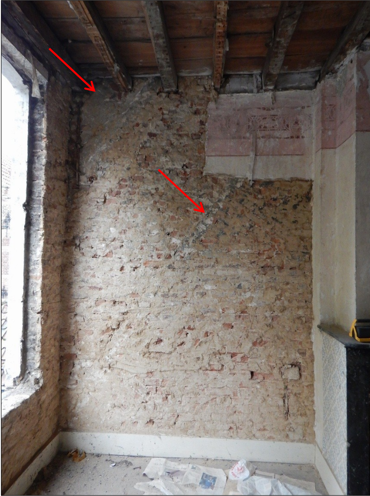
Figuur 13. De bouwsporen van de oudere dakfasen in kamer 38-6 (rood, links van de schouw).
