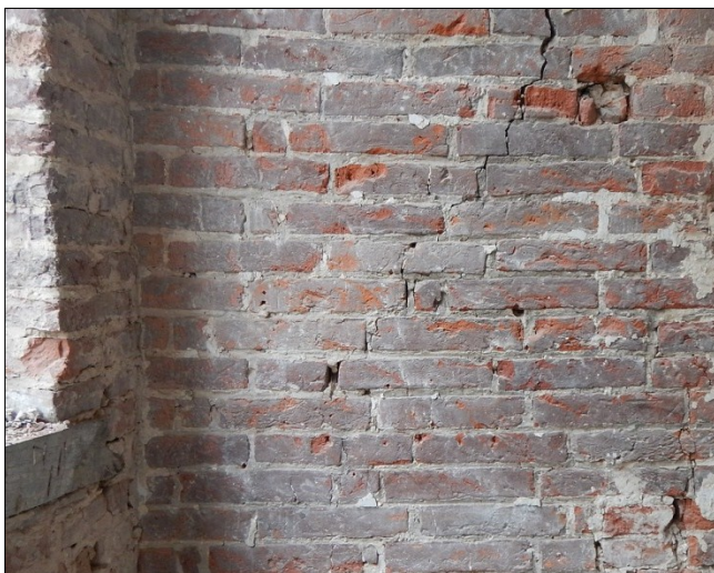
Figuur 23. Detail van de knipvoegen in het metselwerk in kamer 39-5 (links van de schouw).
