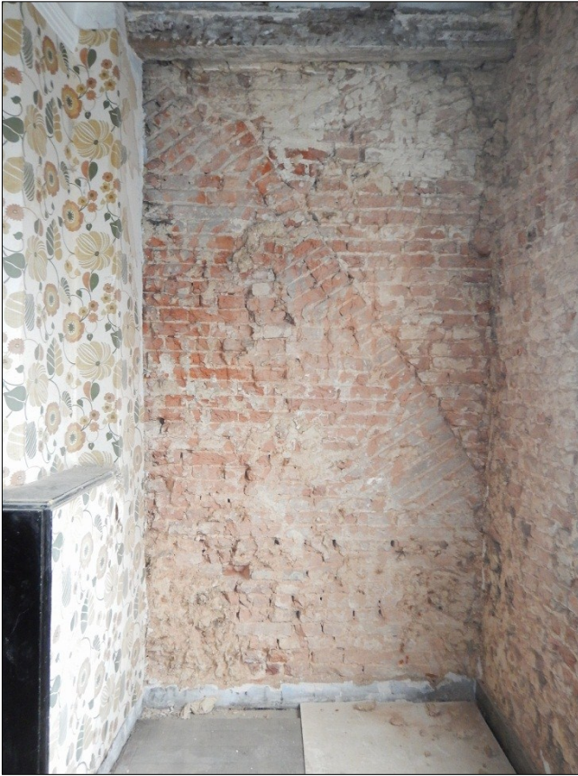
Figuur 10. De bouwsporen van het oudere dak in kamer 37-6.
