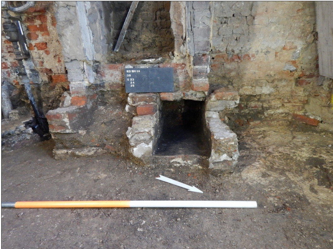
Figuur 75. De fundering van de huidige haard in de aanbouw van nr. 39 (S22, S23, S24 en S25).
