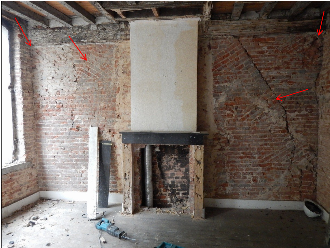
Figuur 22. De bouwsporen van het dak in kamer 39-5.
