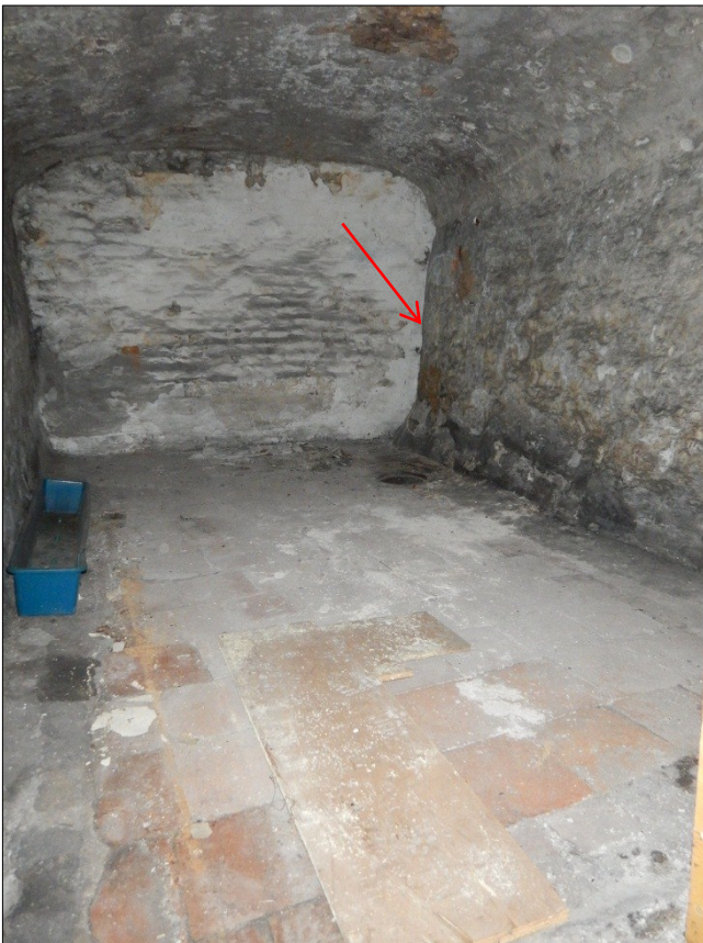
Figuur 19. Kelder B, met de dichtgemetselde achterwand ter hoogte van de knik (achteraan rechts).
