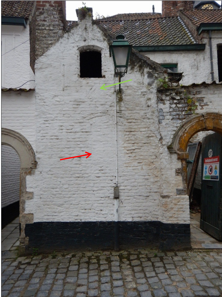
Figuur 8. De straatgevel van ruimte 37-1, met aanduiding van het dichtgemetselde raam (rood) en het bouwspoor van het vroegere dak (groen).
