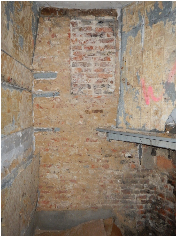
Figuur 12. De dichtgemetselde raamopening aan de binnenzijde van de straatgevel in ruimte 38-1.
