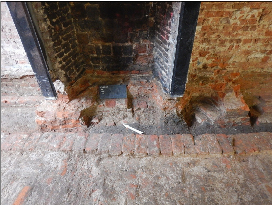
Figuur 88. Haardfunderingen S12 en S13 tegen de oostelijke muur.
