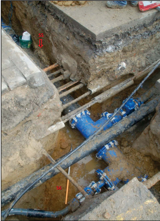
Fig. 14 Station III zicht op S5 en S6 tijdens het onderzoek, onder een wirwar van nutsleidingen en de reeds aangelegde hoofdwaterleiding.
