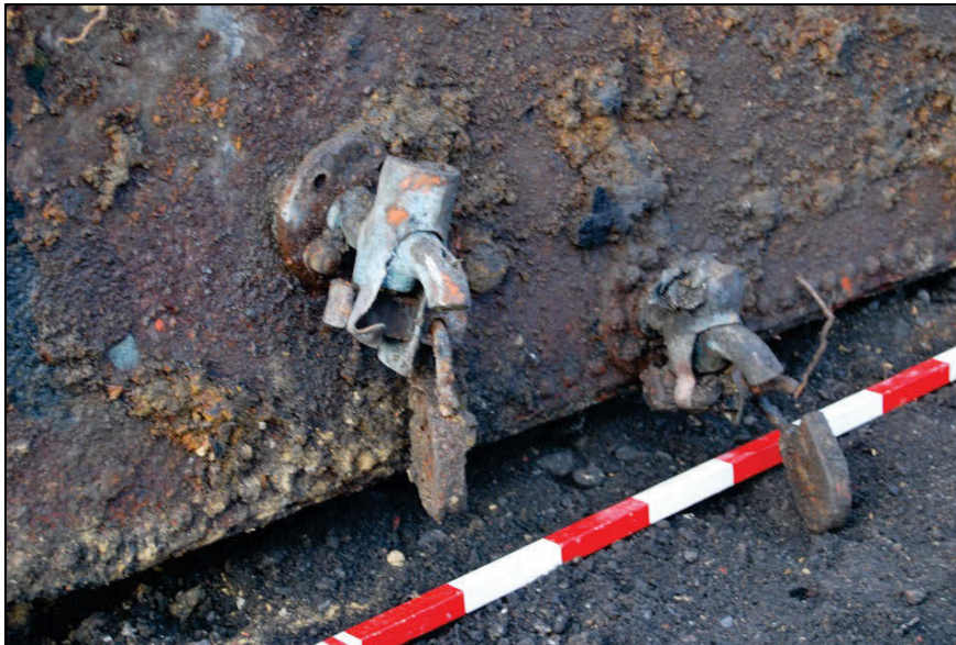
Fig. 10 Onderaan de tank waren 2 kranen aangebracht om.
