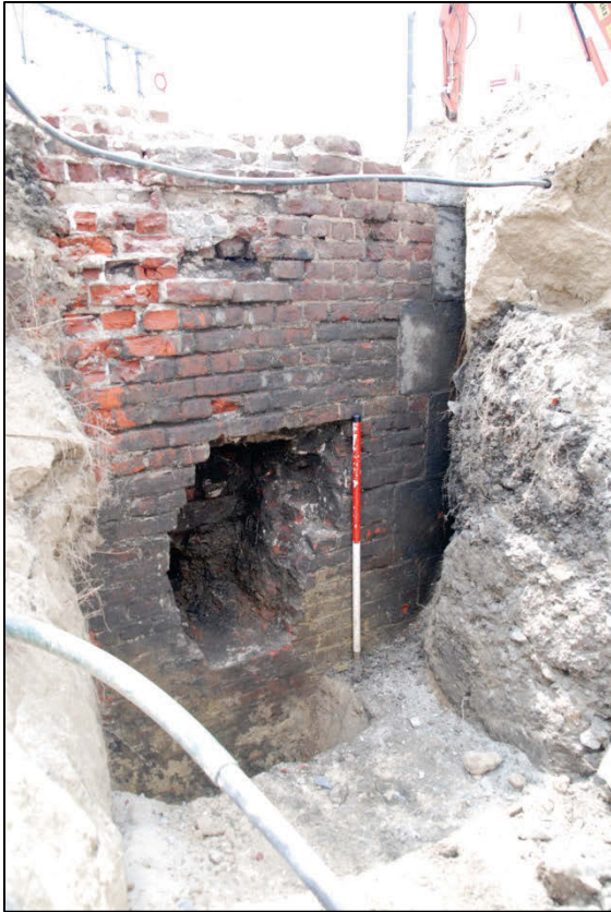
Fig. 12 Station II: zicht op het bruggenhoofd aan de landzijde. Bemerkt de natuurstenen hoekblokken.
