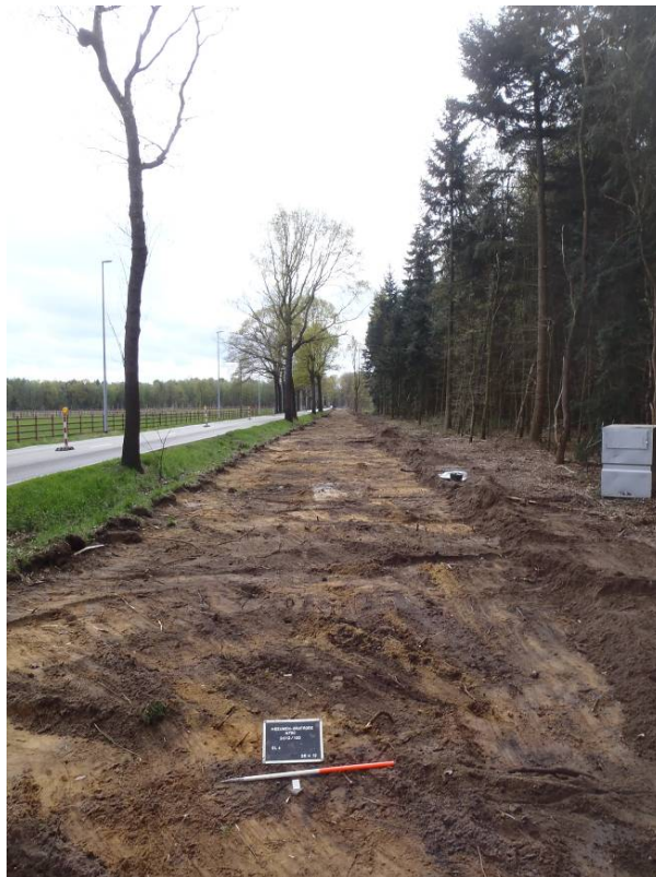
Figuur 7.1 Overzichtsfoto tijdens de graafwerkzaamheden
