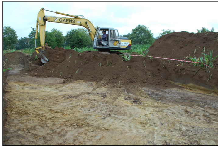
Afb. 8: Aanleg van het vlak.
