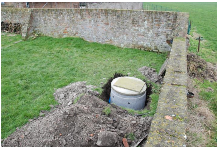
Fig. 1.10 : aanleg nieuwe waterput.
