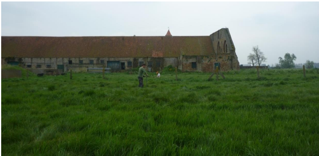
Fig.3.8 : sfeerbeeld van het booronderzoek ten noorden van de schuur
