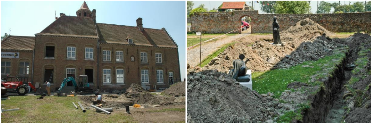
Fig. 1.8: Aanleg IBA en nutsleidingen op het centrale binnenplein bij de herbesteding van het voormalige abtsgebouw (foto links); aanleg nutsleidingen in de zone noord van de voormalige kerkschuur (foto rechts) in juni 2005.
