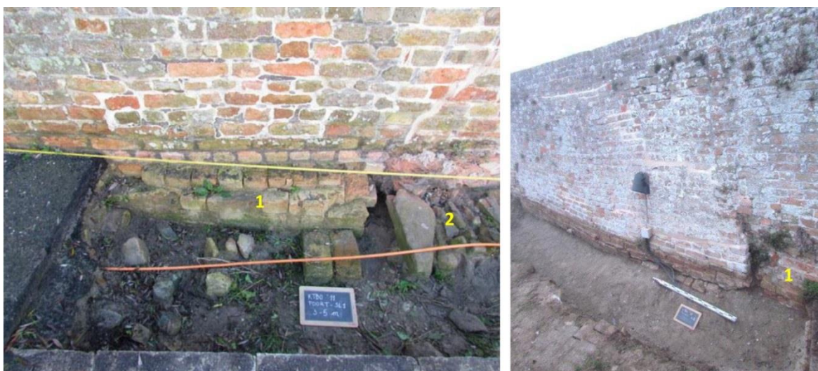
Fig. 1.12 : opnames van de zuidmuur van de oude poort waarbij 1 de originele poortfundering betreft en 2 de oude bestrating (foto's Abdijmuseum Ten Duinen/Alexander Lehouck); linkerfoto : binnenzijde; rechterfoto : buitenzijde
