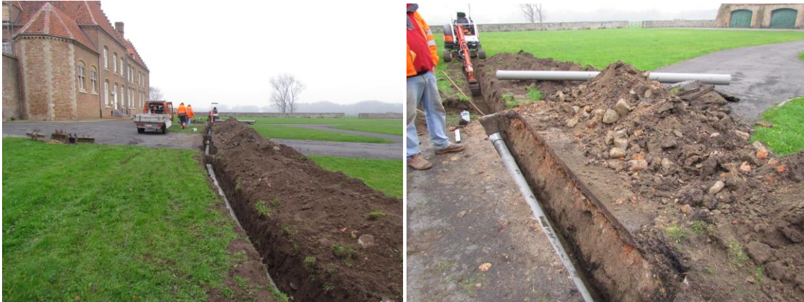
Fig. 1.13 : vernieuwing nutsleidingen op de binnenkoer en ten zuiden van de voormalige abtswoning (foto's links- en rechtsboven); vernieuwing van nutsleidingen op de centrale binnenkoer (foto's links- en rechtsonder). De resten van de oude wegenis liggen net onder de asfalt (foto rechtsonder).
