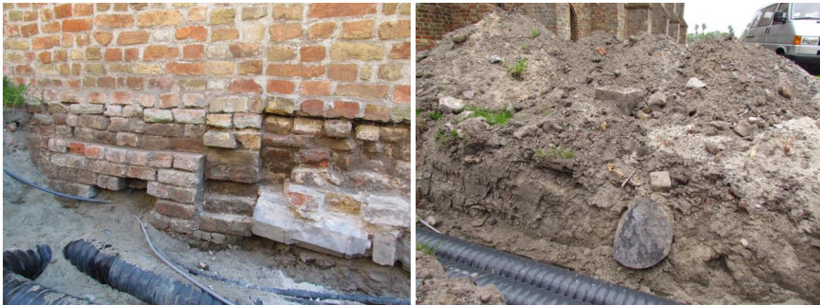
Fig. 1.14 : aanleg sleuf voor de vernieuwing van de nutsleidingen tussen de voormalige kerkschuur en schuur De Geyter (foto's links- en rechtsboven). Hierbij kwamen talrijke stukken architecturale natuursteen boven uit de periode van de middeleeuwen . De foto's links- en rechtsonder tonen respectievelijk een geprofileerde zuilbasis (14de eeuw?) en een zuiltrommel (13de eeuw) in Doornikse steen.
