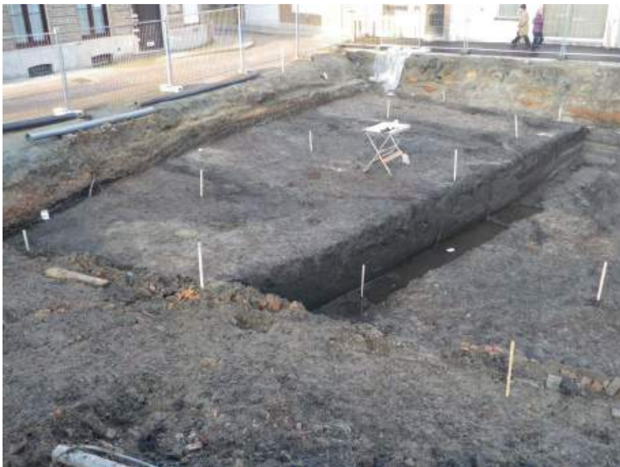
Figuur 3.3.4-105: werkput 4, niveau 1, westzijde
