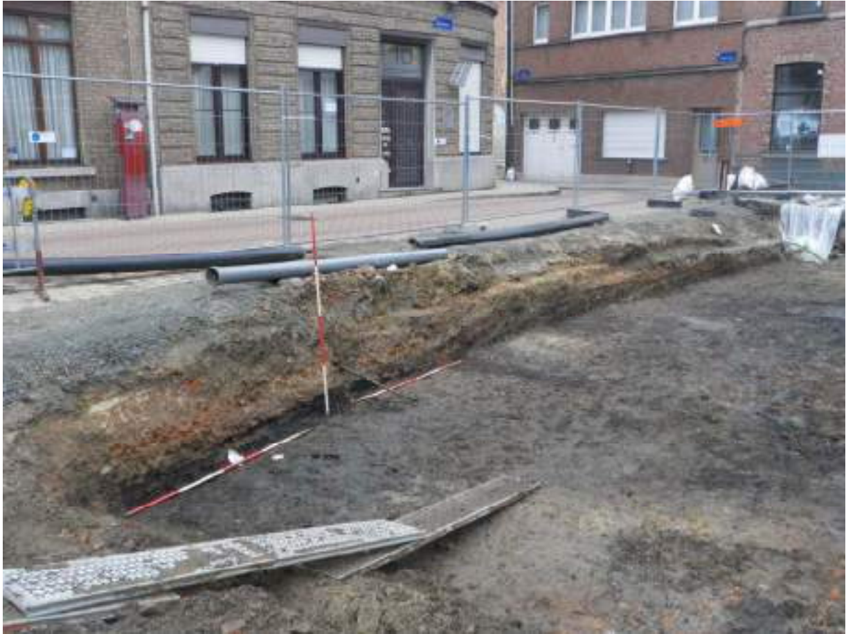
Figuur 3.2.5-35: profiel aan de zijde van de Nieuwe Kapucijnenstraat dat illustreert welke lagen weggegraven werden (in vlak is niveau 1 zichtbaar).
