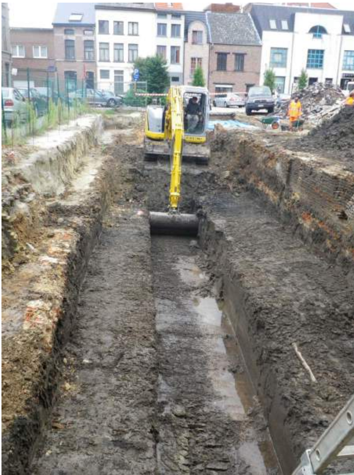
Figuur 3.2.5-9: werkput 1: aanleg niveau 5 onderaan het sleufje
