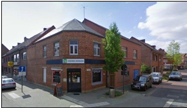
Fig. 7: kijk op het perceel voor de afbraak. (© Google 2013)
