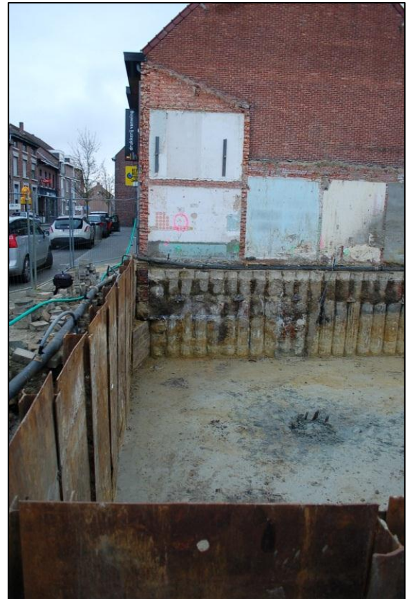
Fig. 11: zuidprofiel van de werkput met in de groutpalen de weerspiegeling van het verdwenen profiel.
