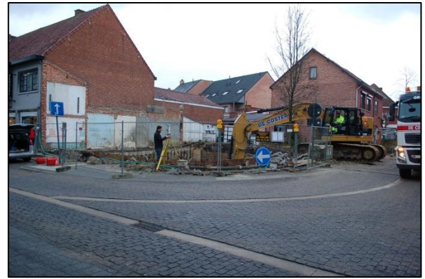
Fig. 8: het inmeten van de omgeving, de werkput en de waterput.
