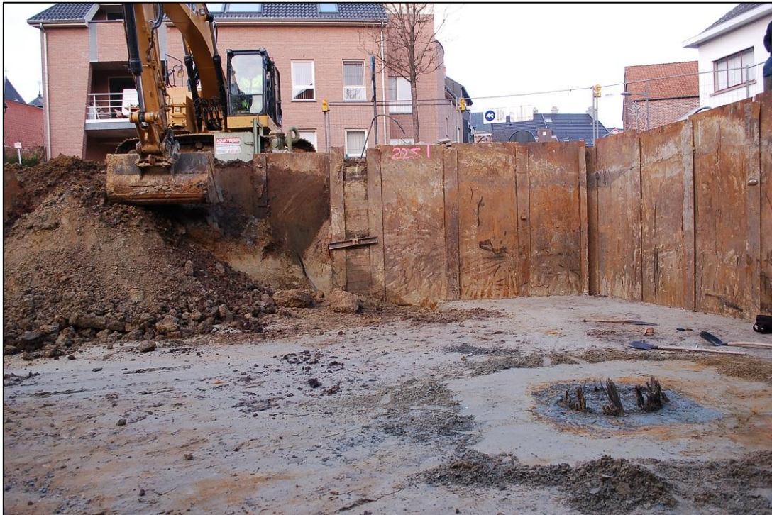
Fig. 1: de werkput tijdens de werken.
