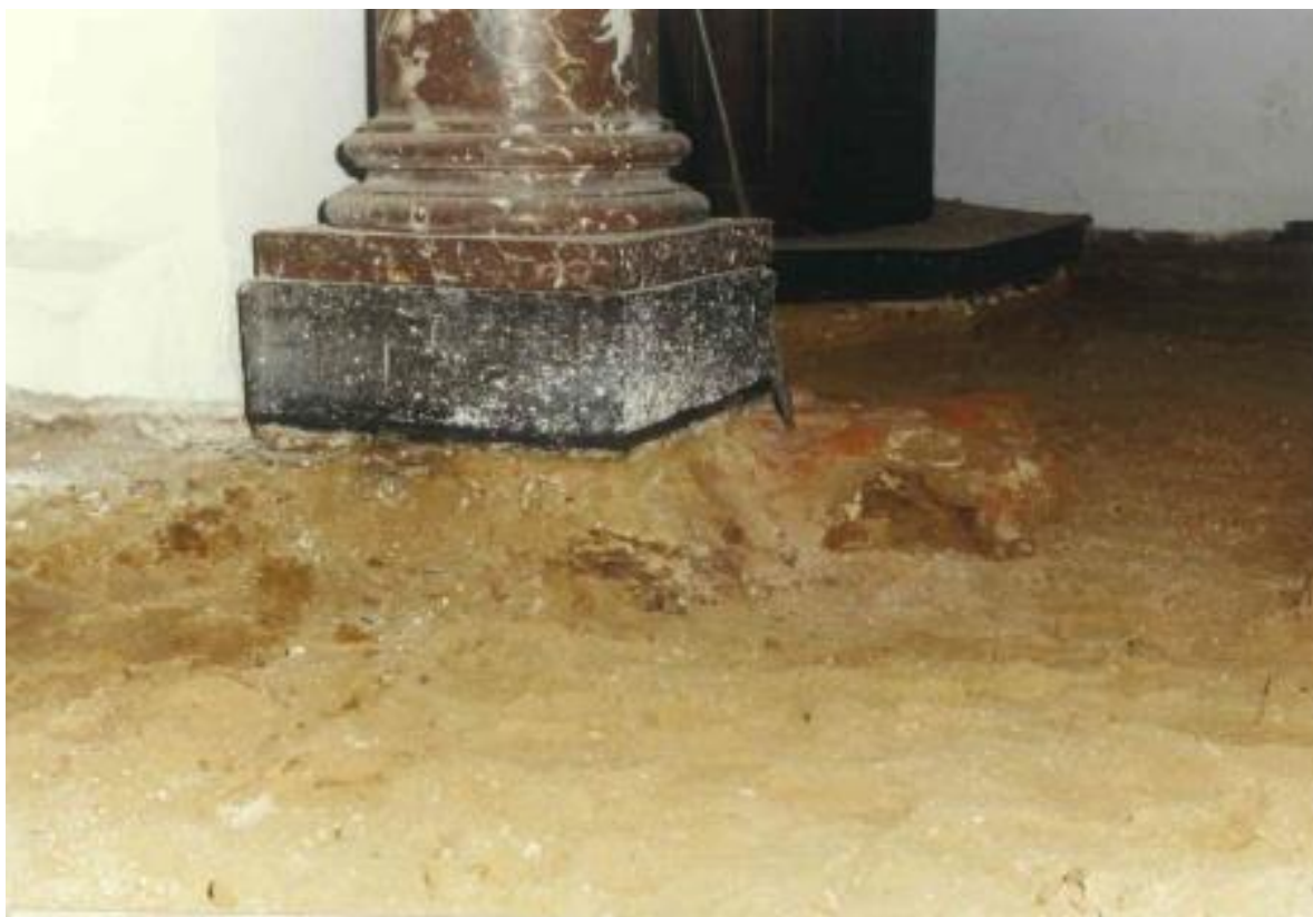
Fig. 4.3: Eerdere uitgraving in het kerkship.
