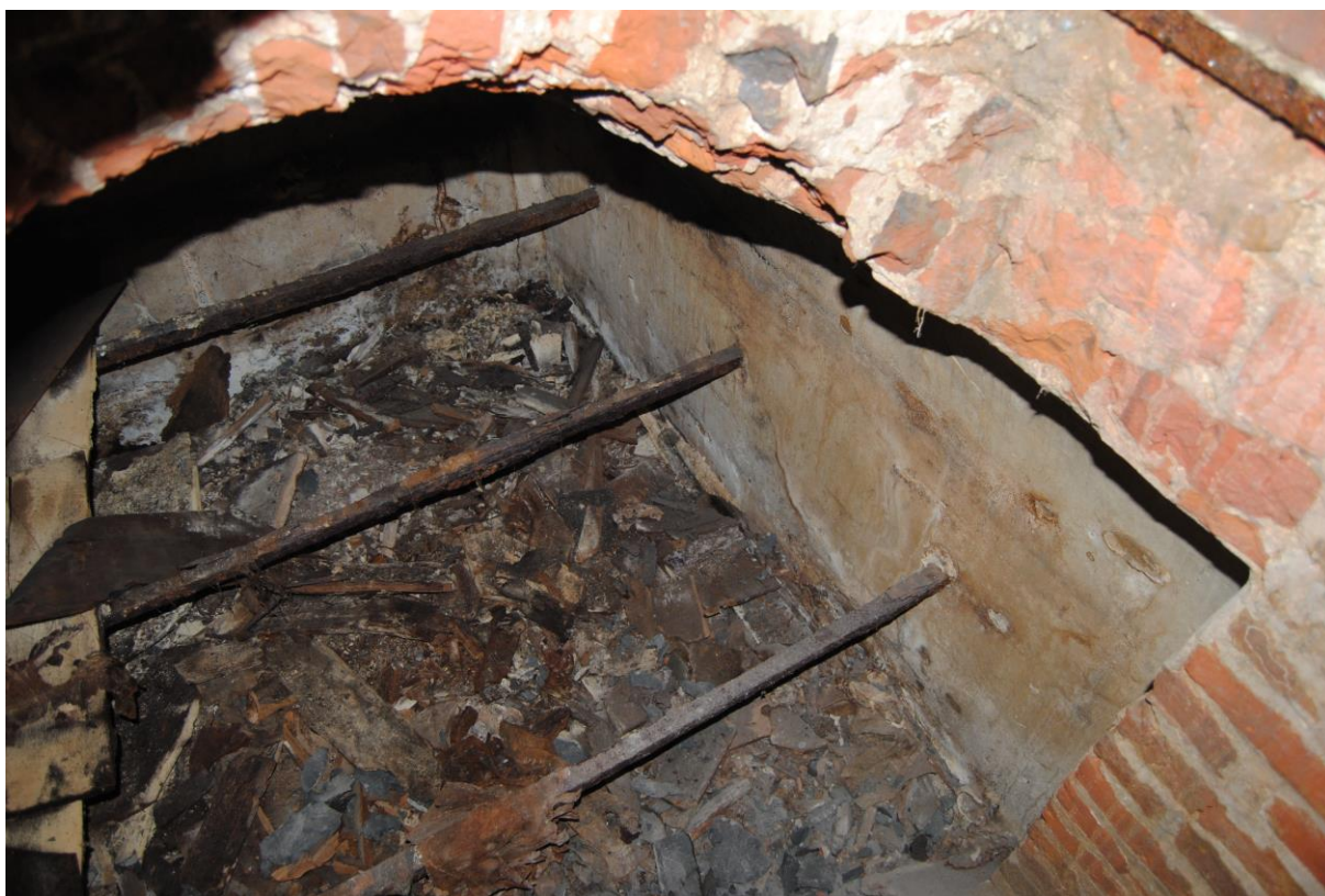
Fig. 5.19: De metalen constructie in de crypte.
