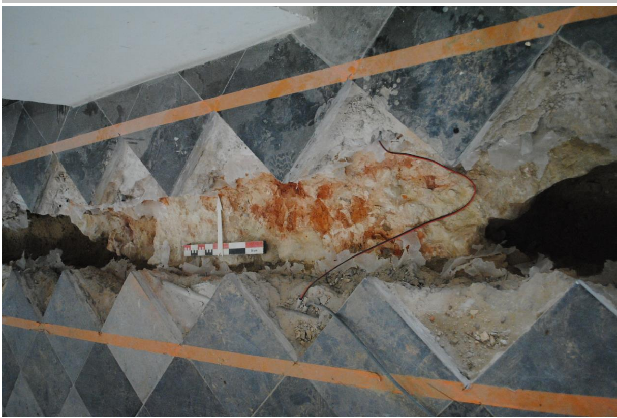
Fig. 5.9: De fundering van de meest oostelijke zuil in de zuidelijke zijbeuk.
