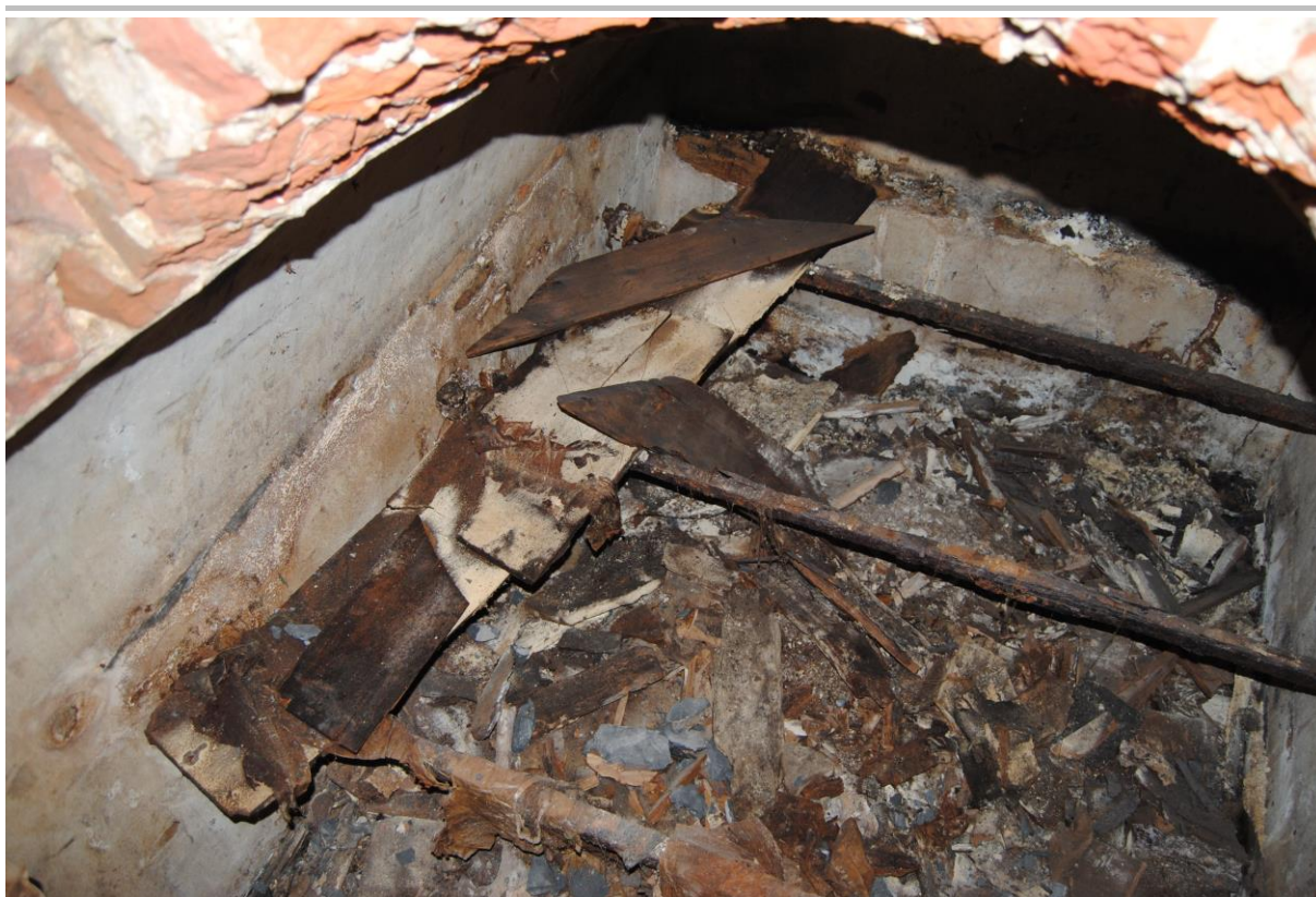
Fig. 5.18: De metalen constructie in de crypte.
