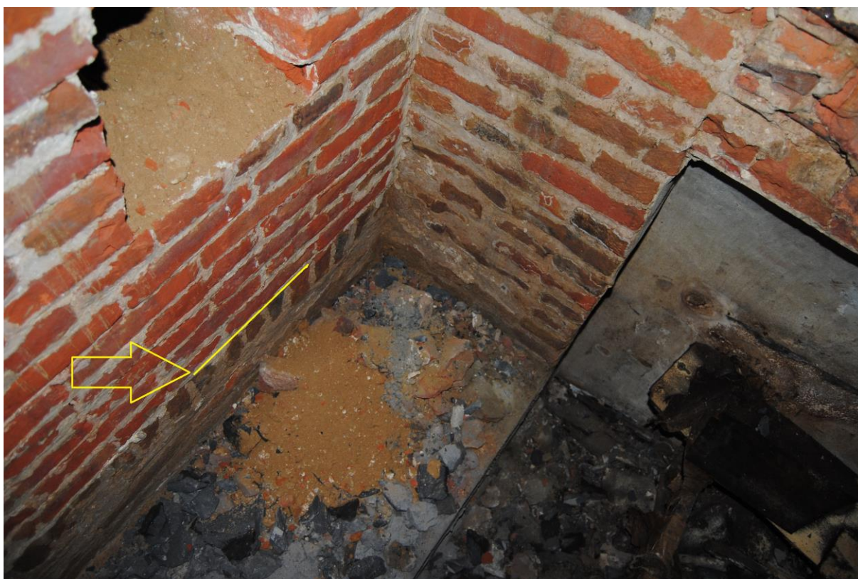
Fig. 5.17: De recenter opgetrokken westmuur op een bestaand muurtje dat in verband staat met de noord- en de zuidmuur van de crypte.
