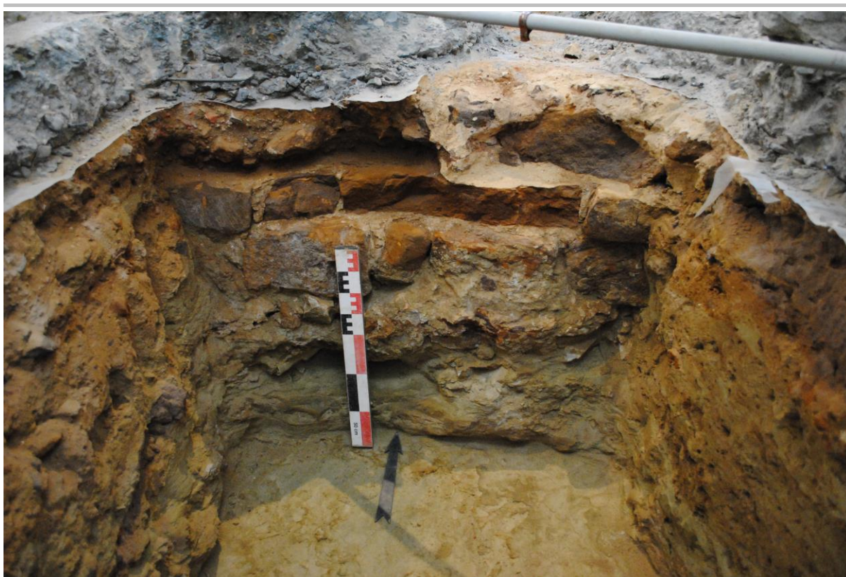
Fig. 5.8: De zuidelijke kettingmuur S 47 in WP 2.
