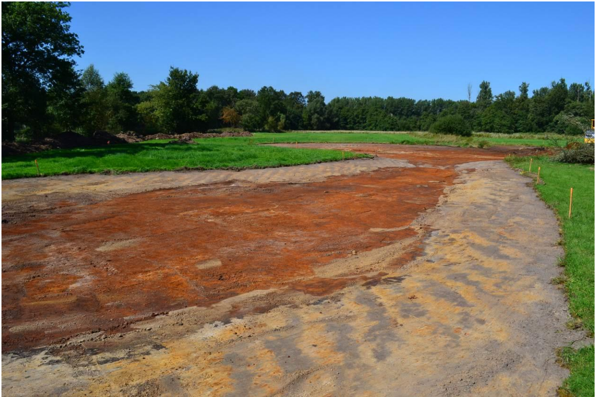
Fig. 4: aanleg van poel. Bemerkt de ijzerrijke horizont.
