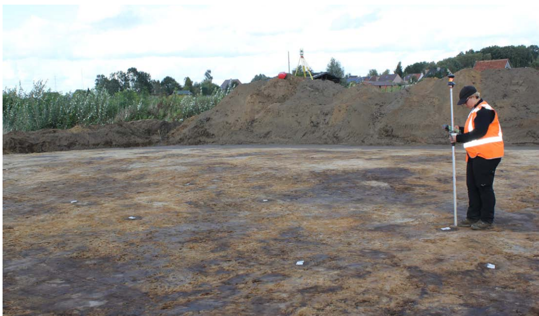
Afb. 2.2 Digitale spoorregistratie met behulp van de Robotic Total Station .
