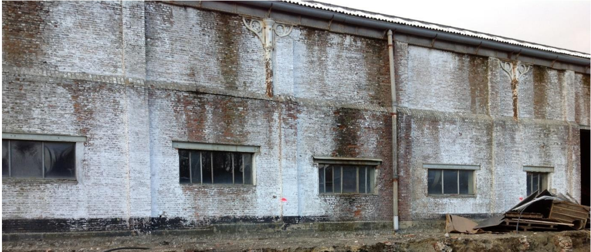
Figuur 33. Zicht op de oostelijke muur van het magazijn. Er zijn nog twee gietijzeren zuilen zichtbaar.
