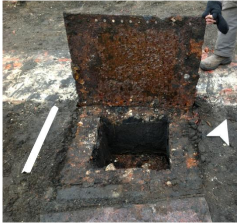
Figuur 16. Detailfoto van de toegang tot een afvoerkanaal.
