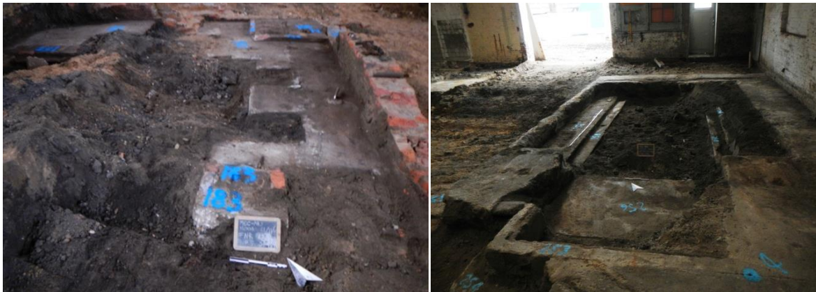
Figuur 40. Overzichtsfoto van deze structuren, met links de bakstenen en rechts de betonnen constructie.
