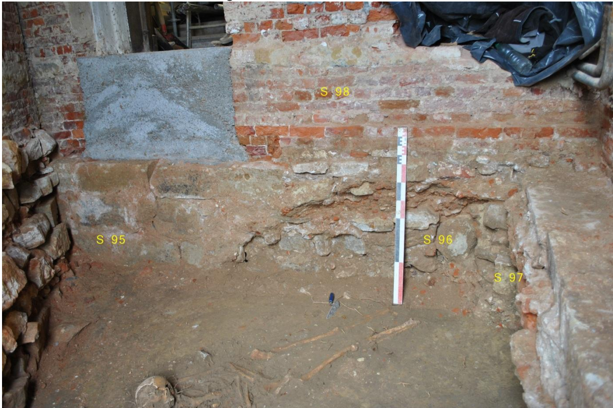
Fig. 27: De zuidmuur van de sacristie.
