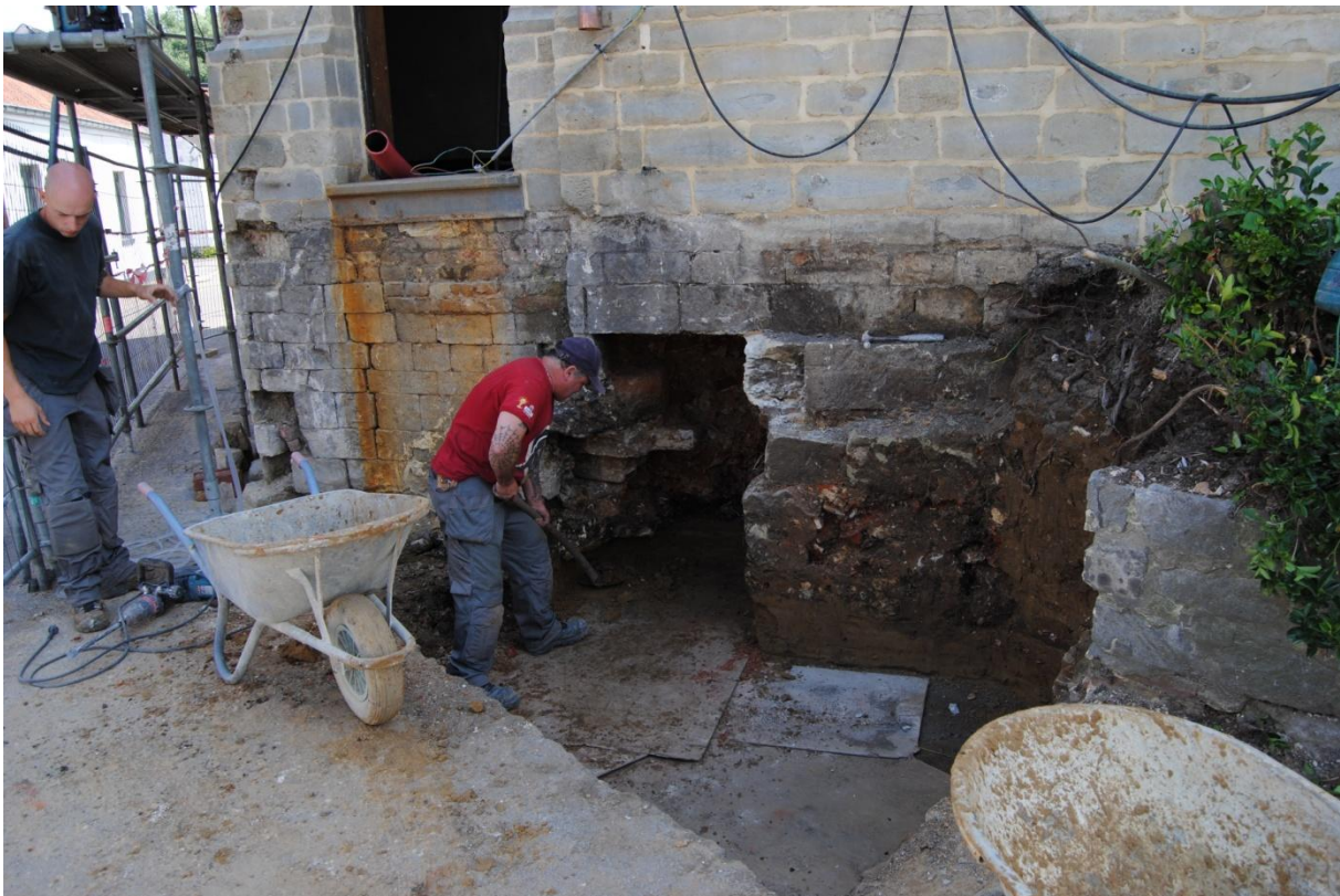
Fig. 9: Het ondermetselen van een gedeelte van de noordelijke zijbeuk.
