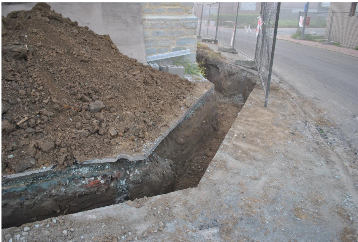
Fig. 36: Sleuf ten behoeve van de regenwaterafvoer ten zuidwesten van de kerk.
