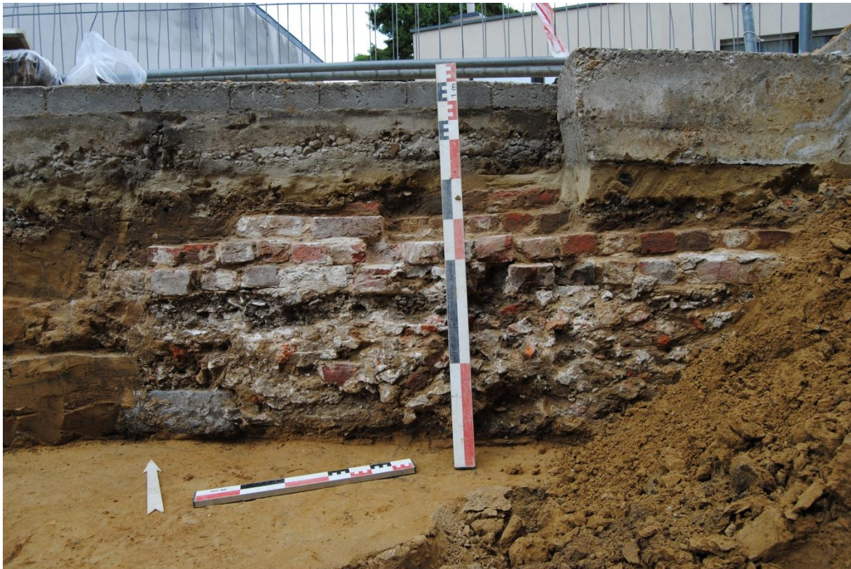
Fig. 23: De kerkhofmuur S 6.
