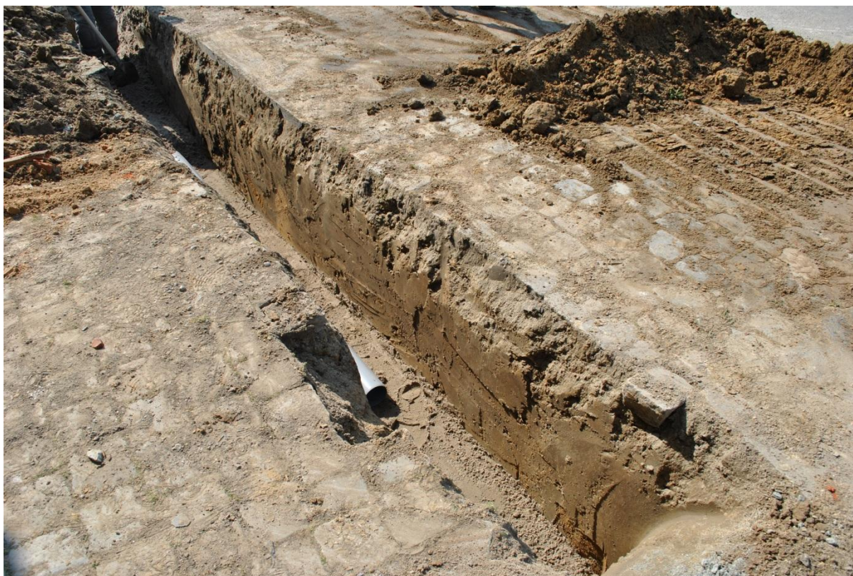
Fig. 35: Sleuf ten behoeve van de regenwaterafvoer ten westen van de kerk.
