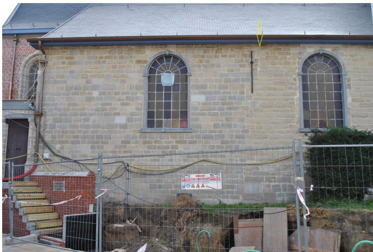
Fig. 28: De bouwnaad in de noordgevel van de noordelijke zijbeuk.
