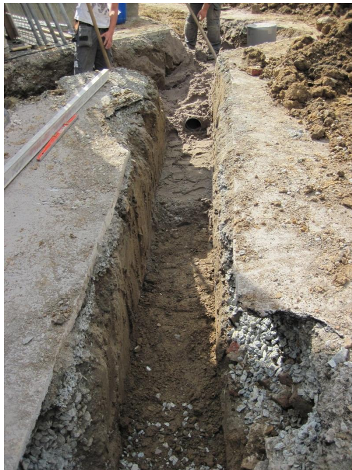
Fig. 10: De sleuven voor de regenwaterafvoer.
