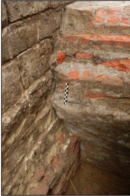
Fig. 19: bouwnaad tussen de oorspronkelijke oostelijke fundering en de bijkomende fundering
