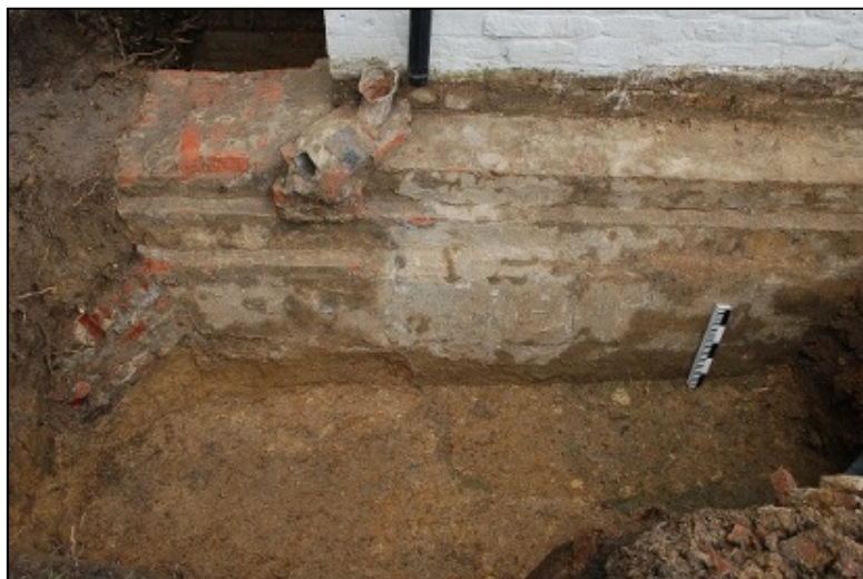
Fig. 14: de funderingsconstructie aan de noordzijde van de pastorie.
