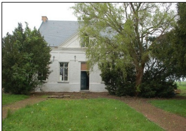
Fig. 4: zicht op de pastorie tijdens de restauratie werken.
