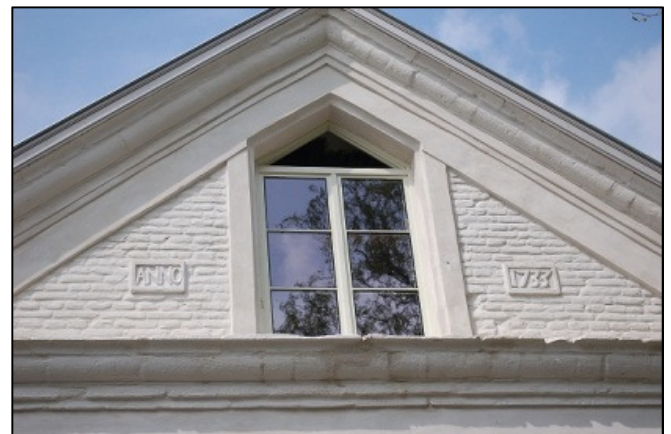
Fig. 5: de bouwdatum (1733) van de laatst gebouwde pastorie in de gevelstenen in het fronton.
