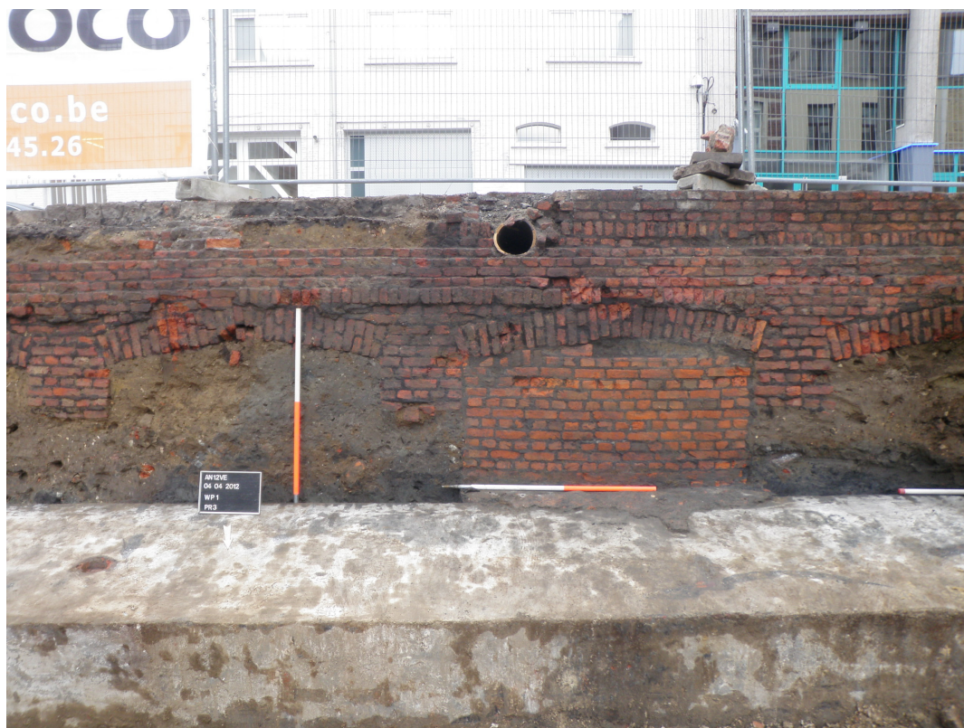
Afbeelding 41: Overzichtsfoto van een deel van de recente funderingen die boven de contrescarp zijn opgetrokken.
