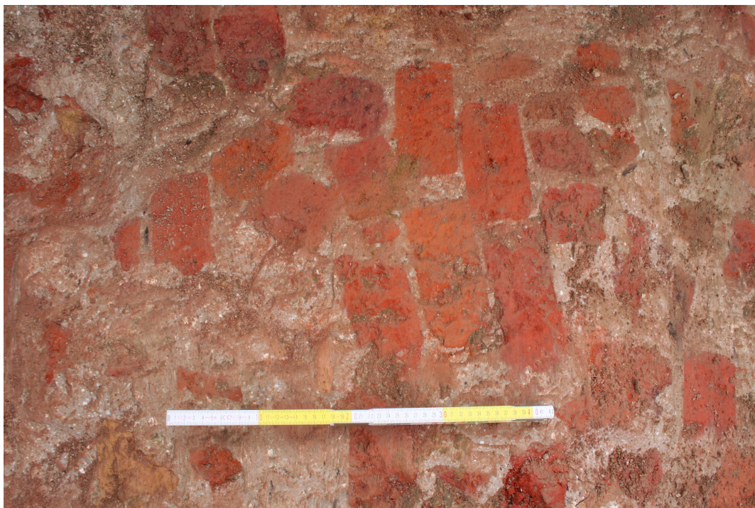
Afbeelding 40: opgekuiste binnenzijde van het bakstenen massief vlak voor profiel 6.
