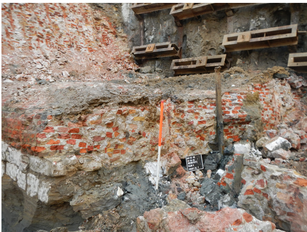
Afbeelding 36: Houten paal vastgesteld tijdens de sloop.
