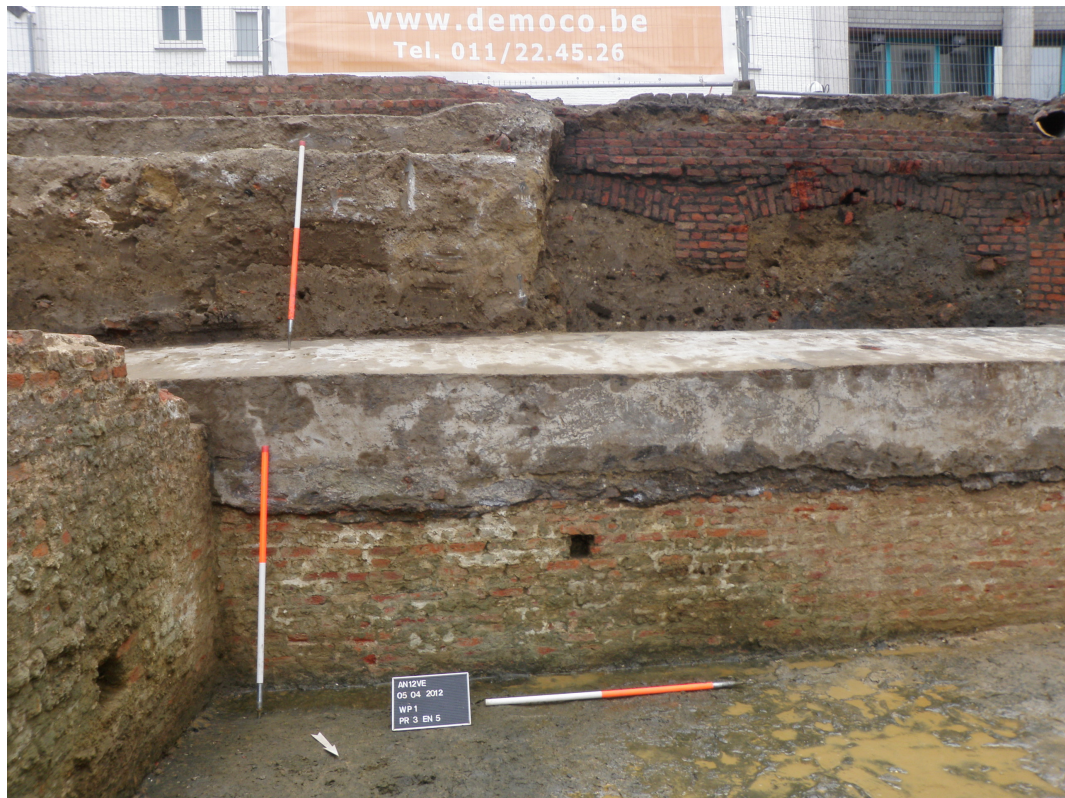
Afbeelding 31: Foto van een deel van de contrescarp waarbij de constructieholtes duidelijke herkenbaar zijn.
