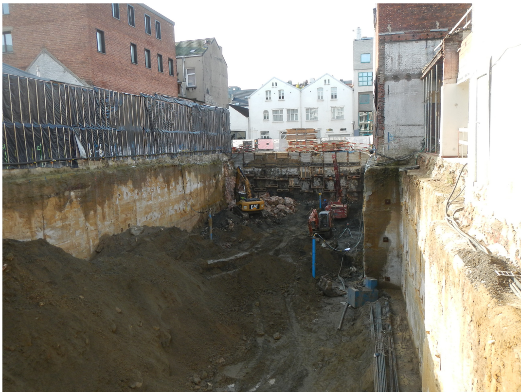
Afbeelding 22: Afbraak van de onderste fase (niveau -3) van het muurwerk.
